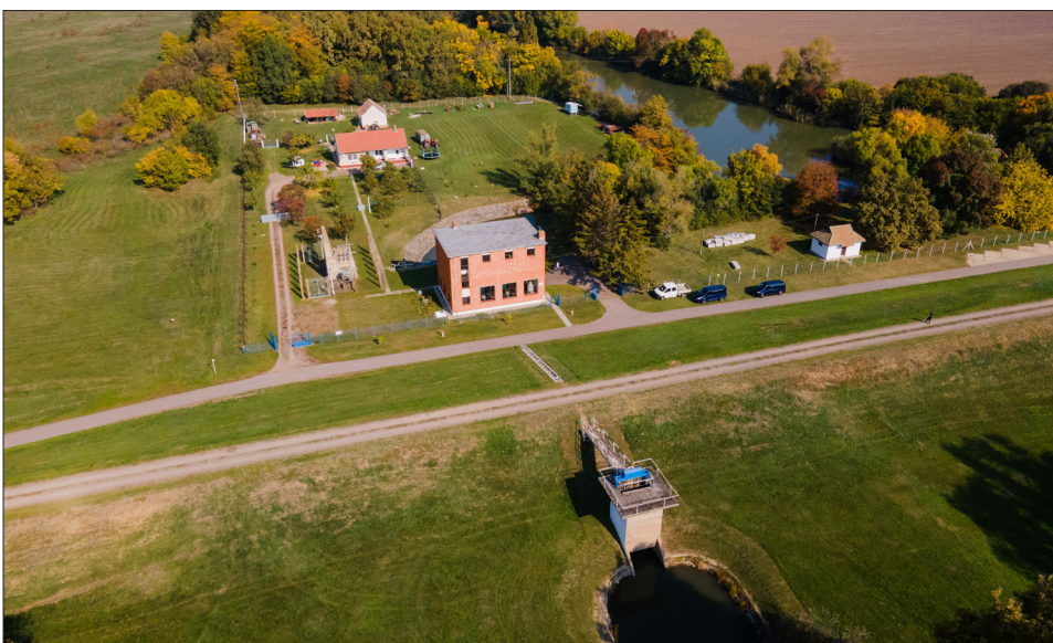
A Peresi szivattyútelep
