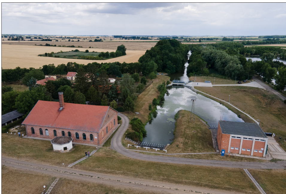
A Kernye I. szivattyútelep rendezett, festői környezete
