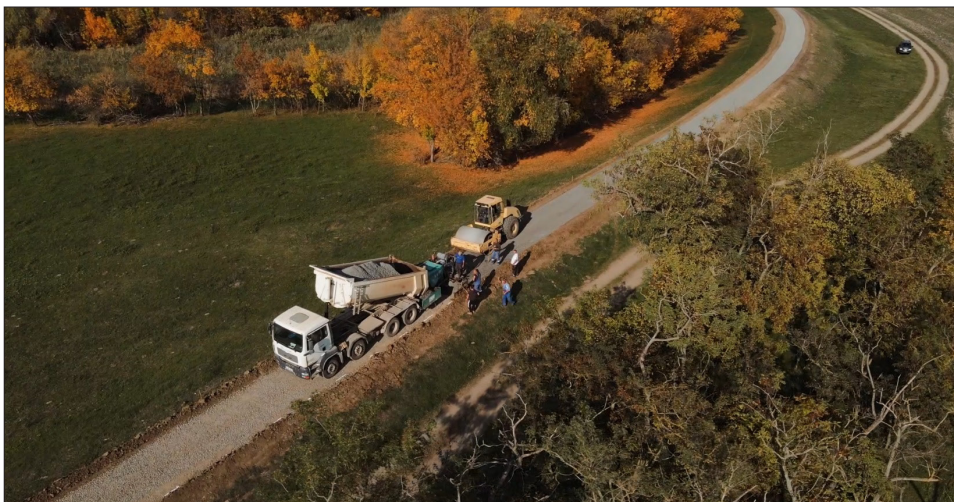
A Szandazugi gátórtelep és Ballai híd-Csurgói gátórtelep között szórtút építése
