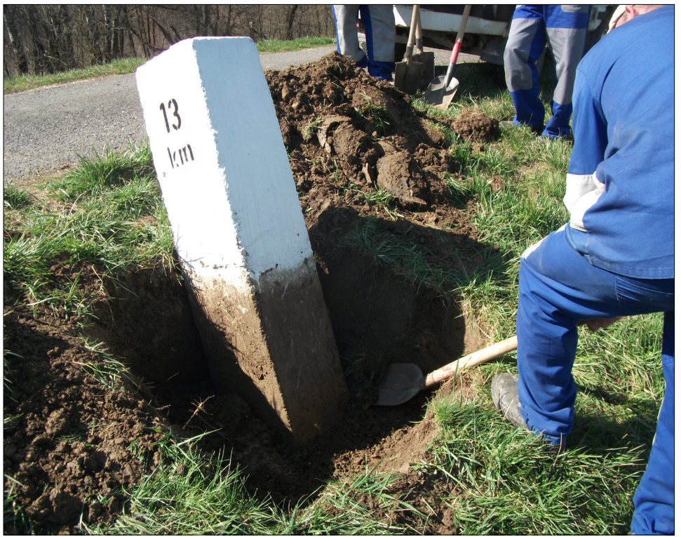
A Kettős-Körös jobb partján lévő szelvénykő cseréje
