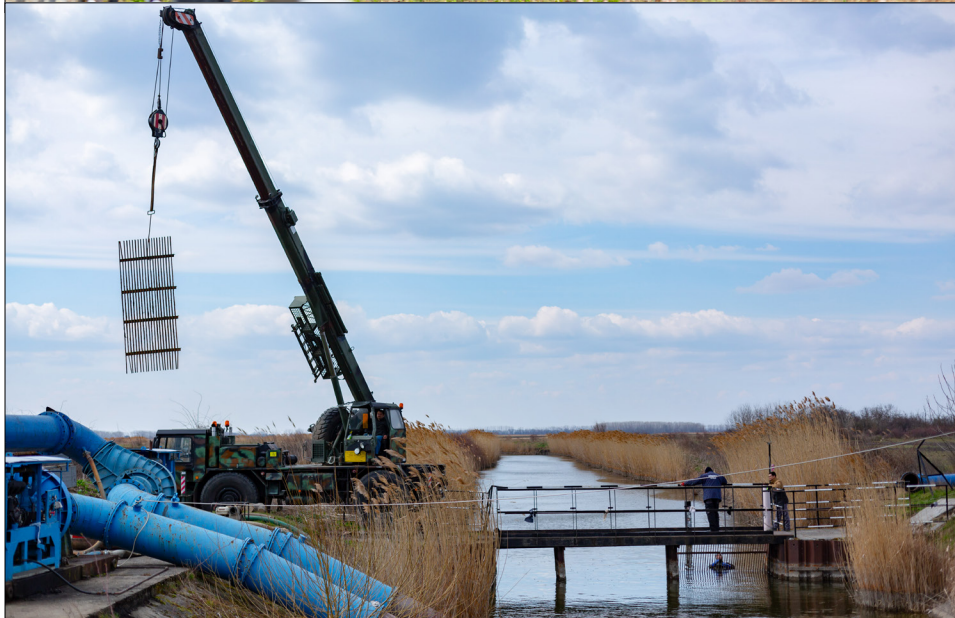
Dögös I. számú öntözővíz átemelő szivattyútelep beüzemelésének előkészítése
