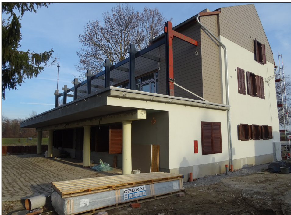
Szanazugi Árvízvédelmi Központ épülete
