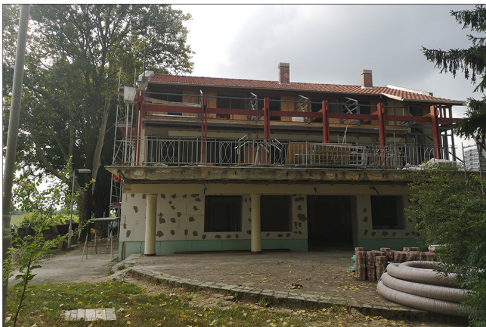
A Szanazugi Árvízvédelmi Központ rekonstrukciója
