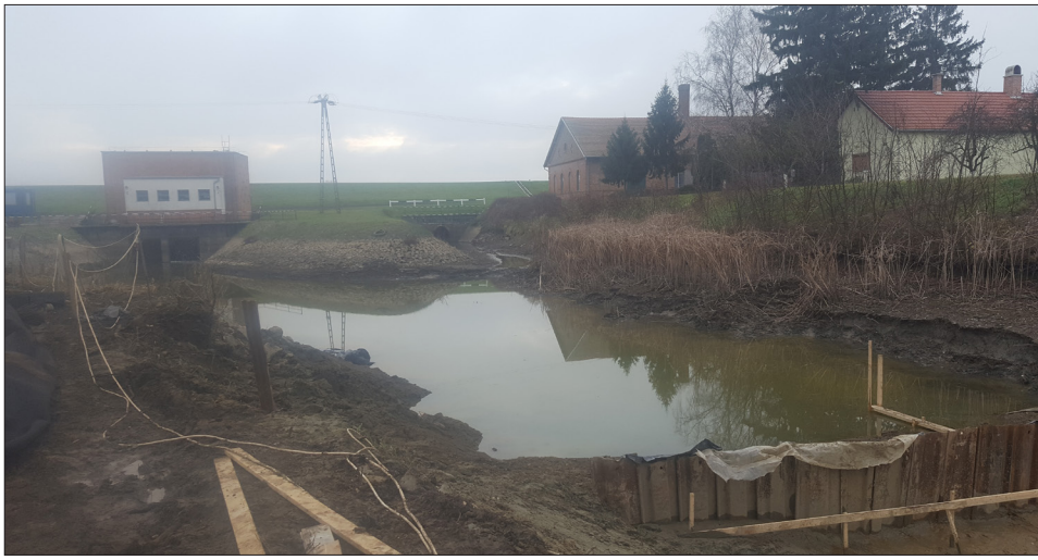
Ideiglenes elzárás a Kernozei szivattyútelepek előtt
