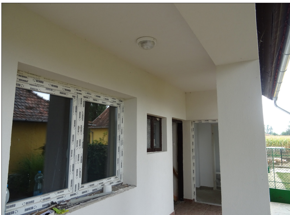
Nyílászáró csere a Körösszakáli gátórháznál
