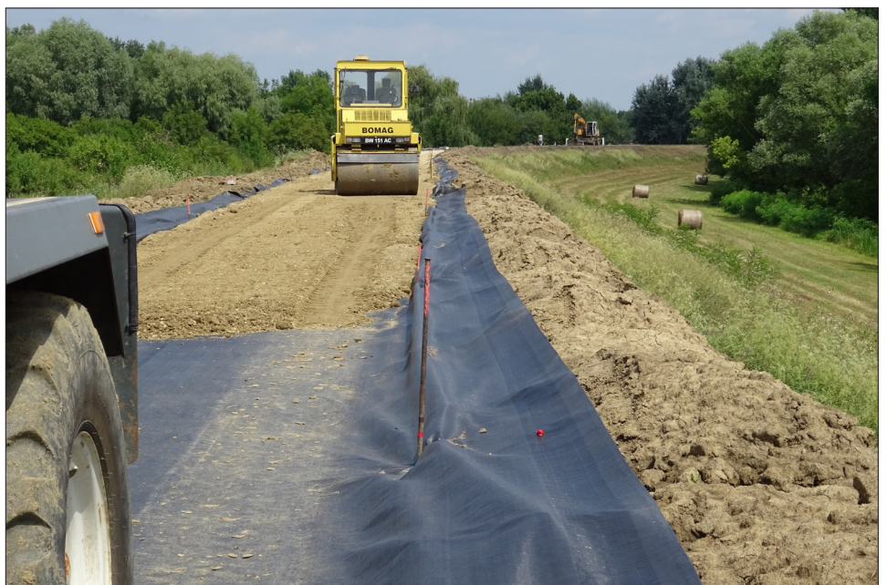
A töltéskoronán épülő út munkálatai
