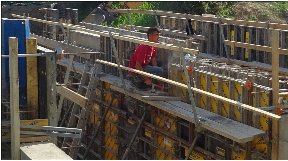
Mozgó gereb műtárgy zsaluzás, betonozás
