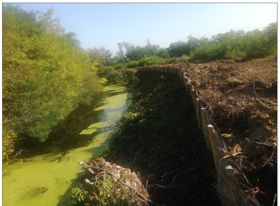
Szeghalmi övcsatorna biológiai támfal építés
