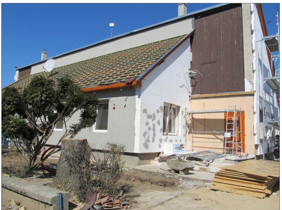
Kivitelezés előrehaladása - Szolgálati lakások
