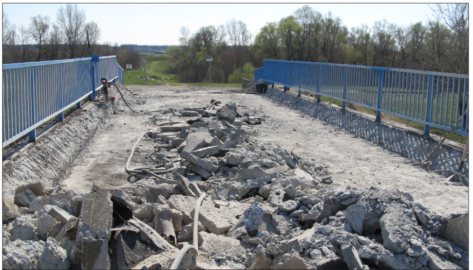
Bontási munkálatok a duzzasztó hídján
