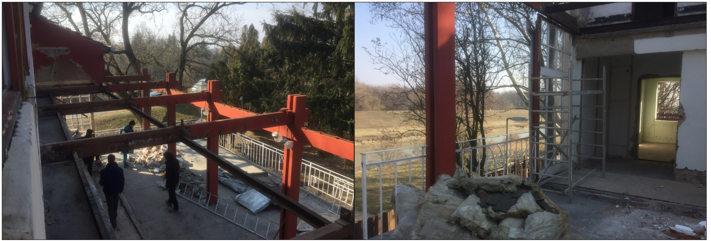
Szanazugi Árvízvédelmi Központ a bontási munkák ideje alatt
