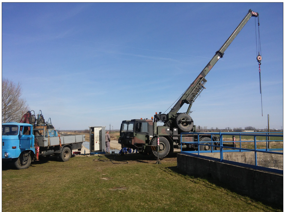
Szivattyúk daruval történő beemelése, majd beüzemelése
