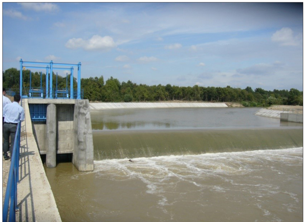
A halak vándorlásának elősegítése céljából a műtárgy bal oldalán hallépcső épült
