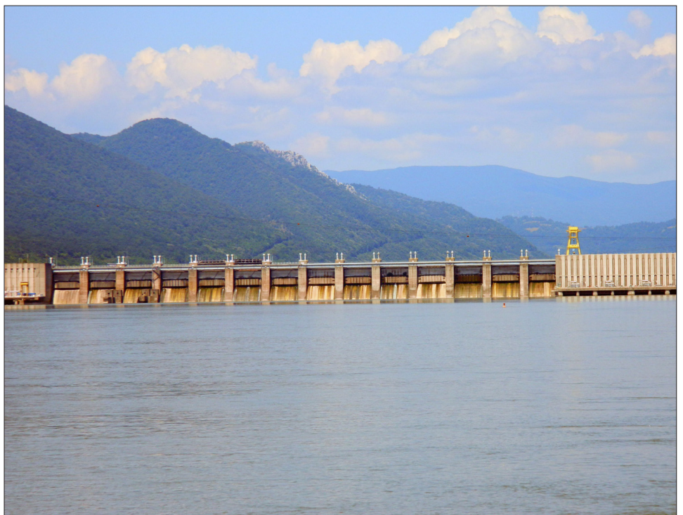
A Vaskapu vízerőmű duzzasztógátja
