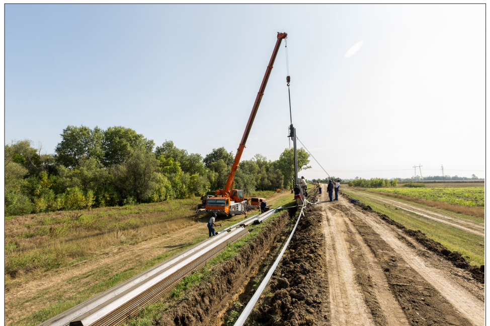
Acél szádfal építése a Hortobágy-Berettyónál
