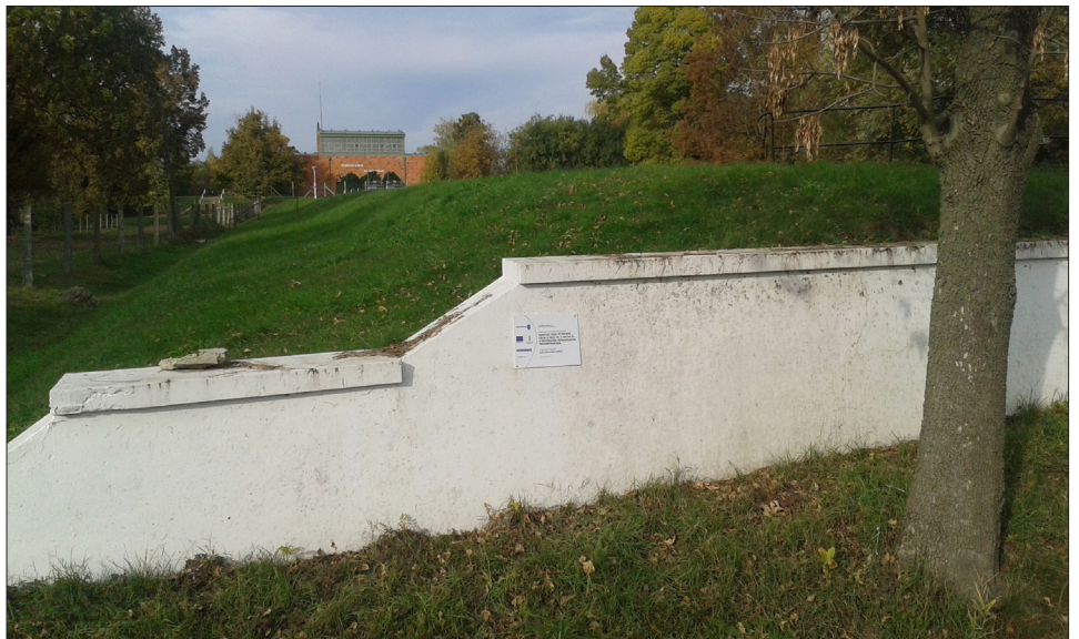
A Szarvas-Kákai szivattyútelep
