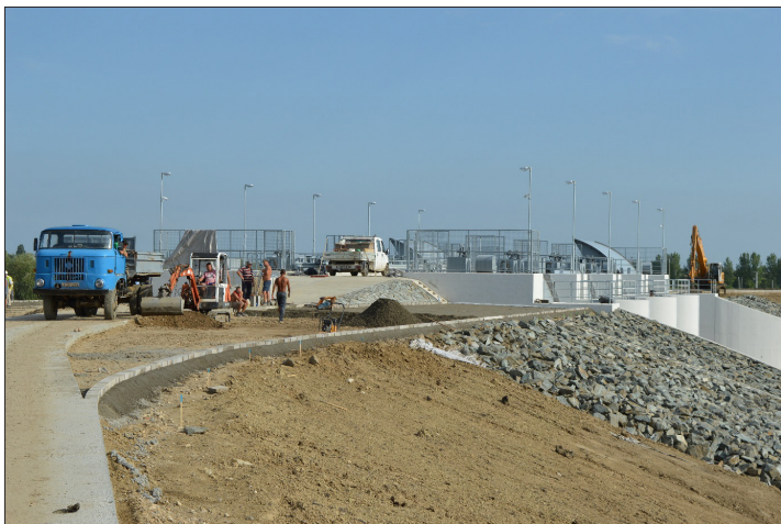
Kisdelta vízbeeresztő műtárgy melletti térburkolat építése
