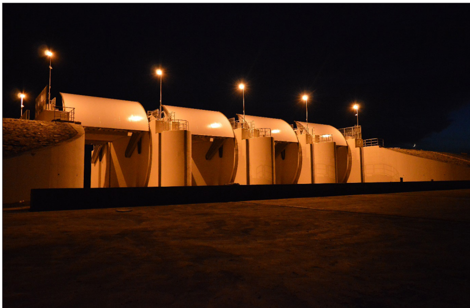
Mályvádi alsó vízbeeresztő műtárgy éjszakai térvilágítása
