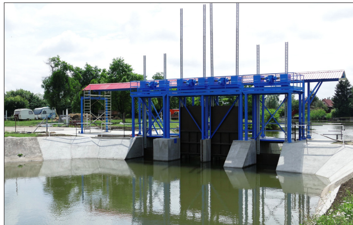
Torkolati zsilip, vízszint szabályozó műtárgy
