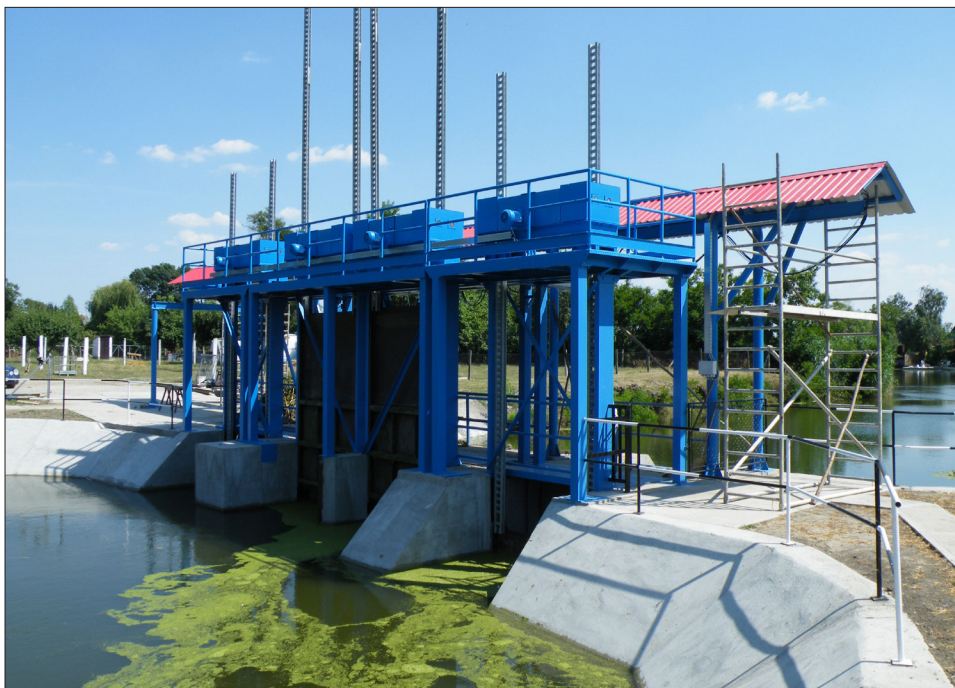
Torkolati vízszintszabályozó műtárgy
