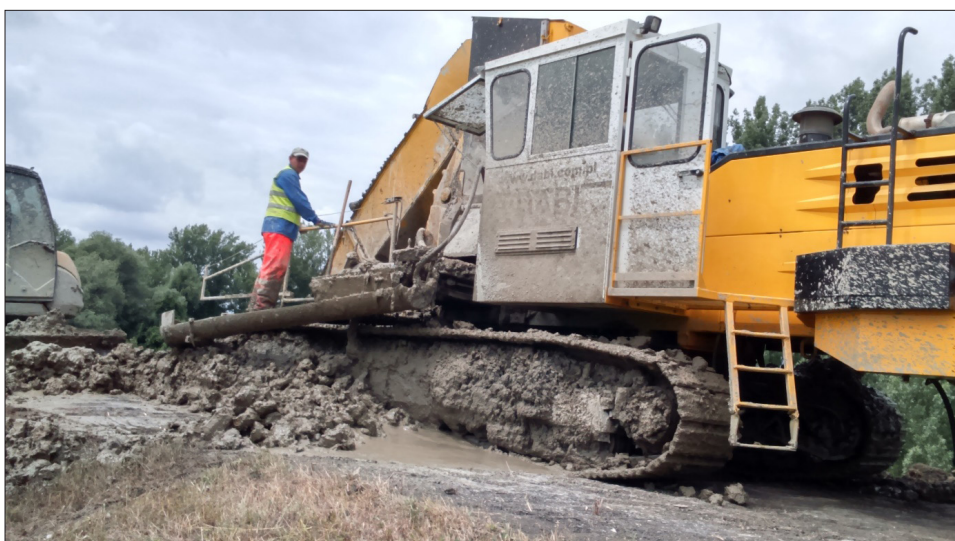
Önszilárduló résfal kaparólánccal vezérgép
