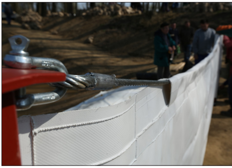
A flexibilis gátfal felső befogása
