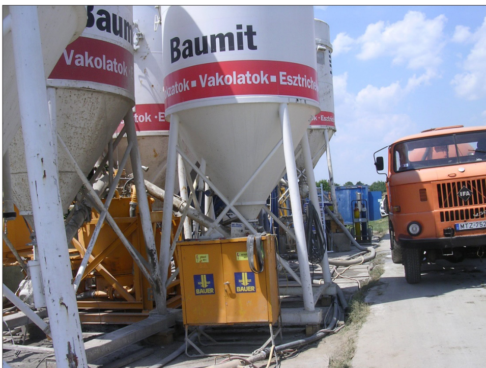
Önszilárduló résfal kötőanyag keverőtelepe
