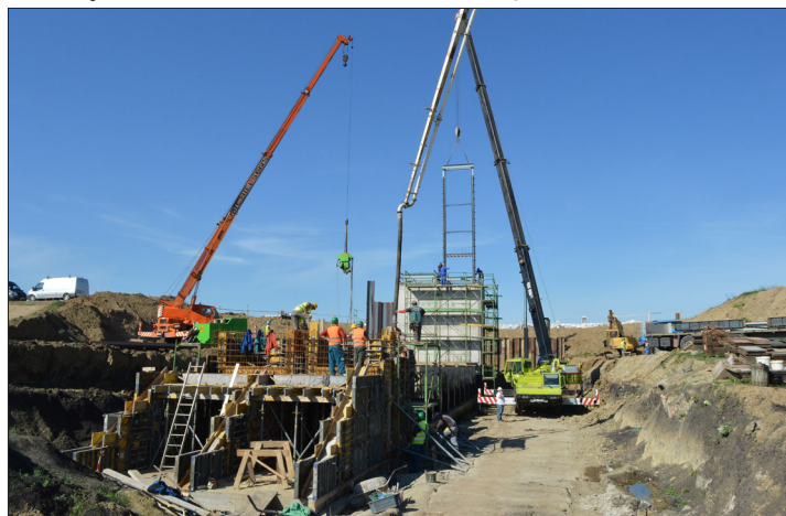
Felső vízvisszavezető mütárgy, elzáró szerkezet beépítése
