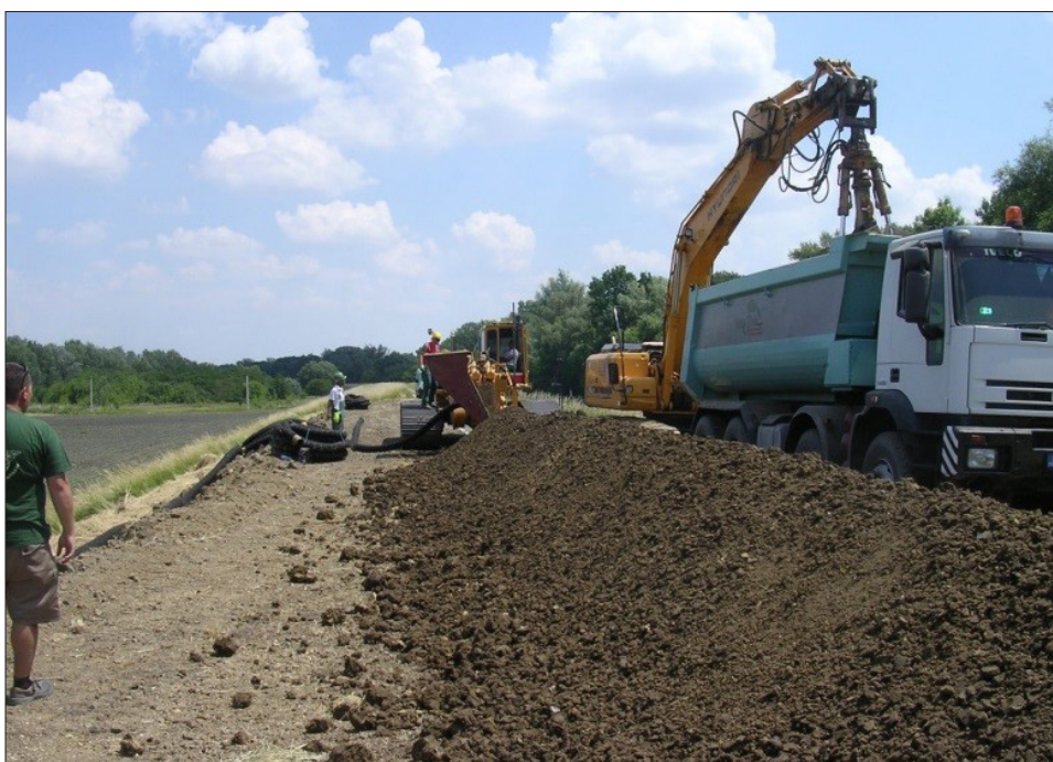
Drénezett kavicszivárgó fal építés géplánca munka közben
