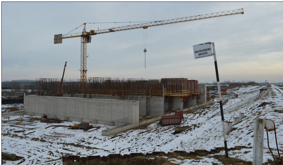
Kisdelta vízbeeresztő műtárgy pilléreinek építése
