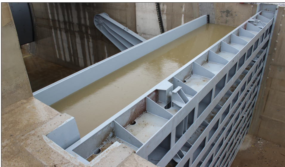
Mályvád - Felső vízbeeresztő műtárgy, vízzárósági próba
