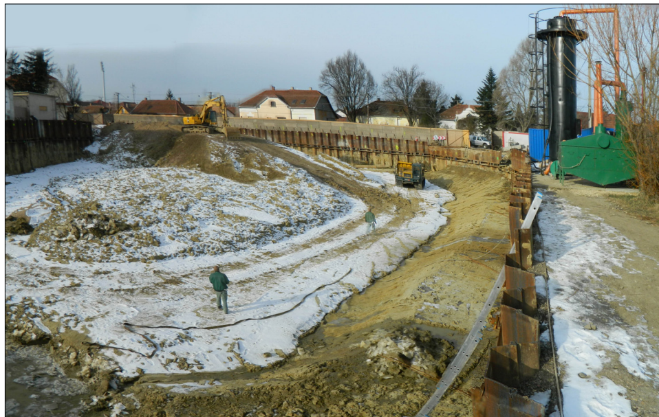
A munkaterület jelenlegi állapota
