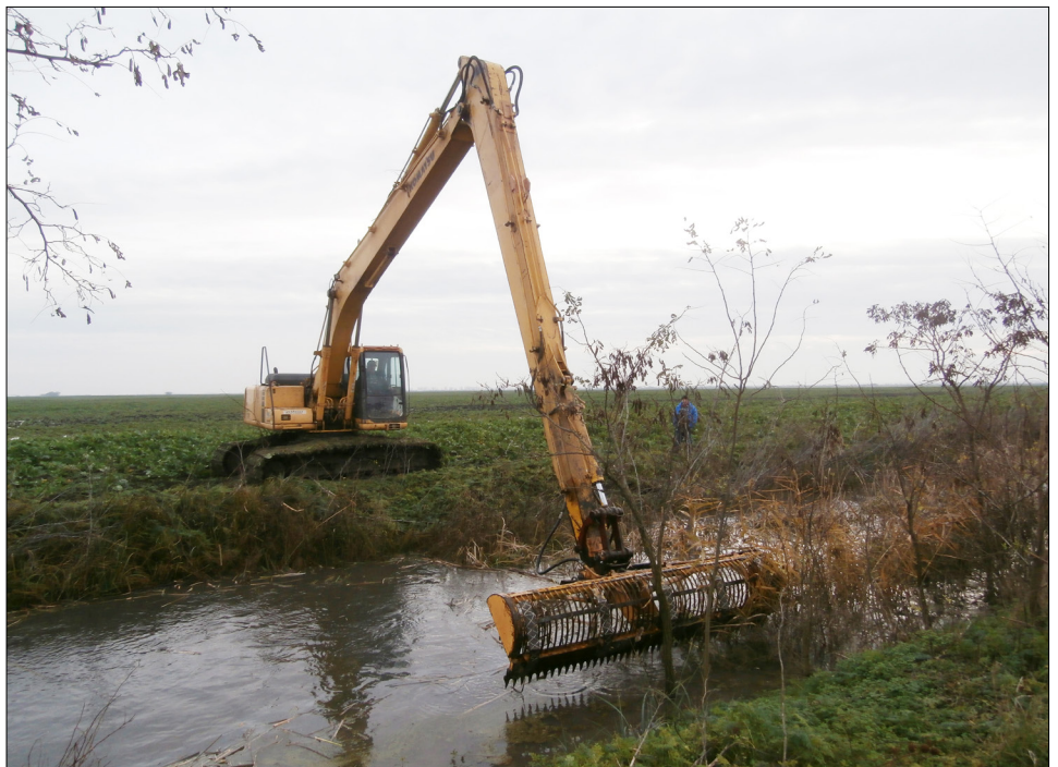
Vízfolyás gátló akadályok eltávolítása
