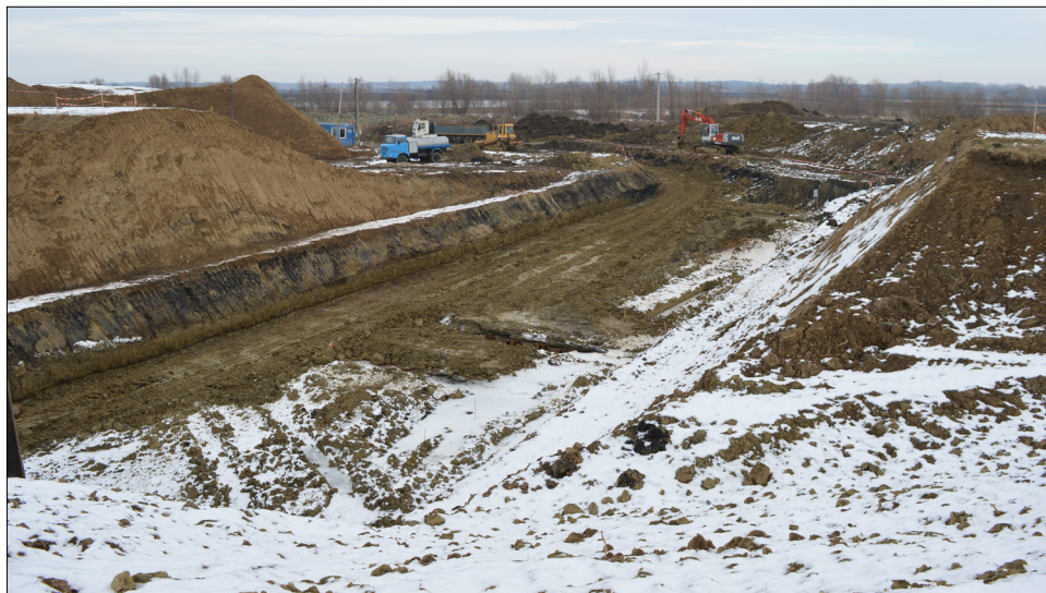
Kisdelta víz visszavezető műtárgy munkagödör
