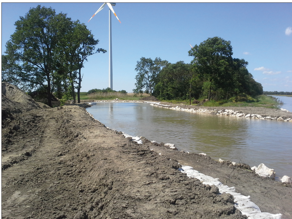
Lajtai duzzasztóművet megkerülő csatorna földgátjának magasítása
