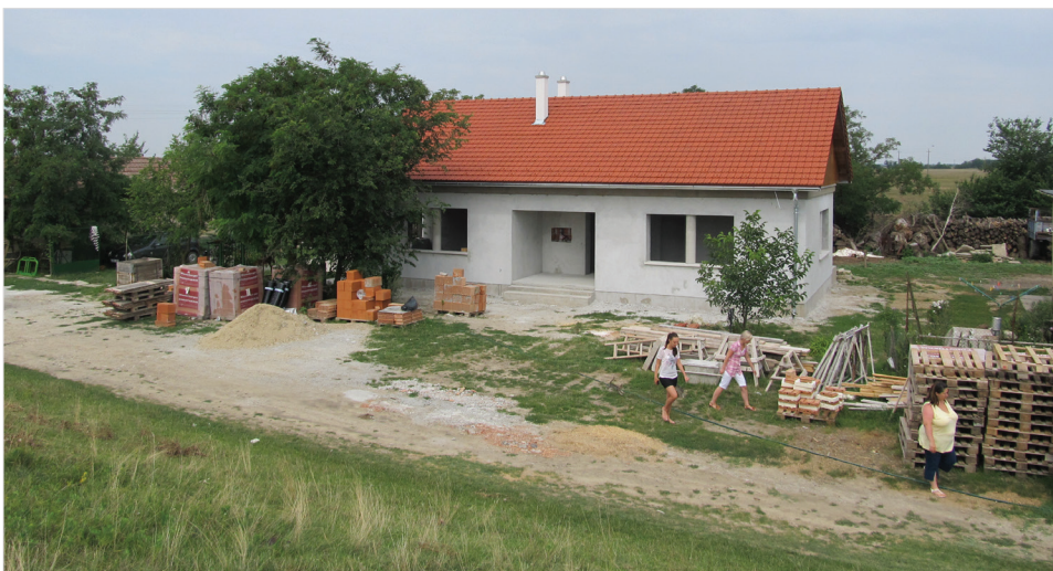
Csíkeri gátórház felújítása
