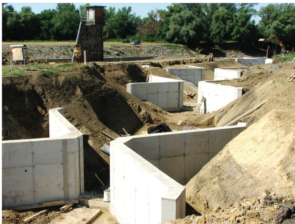
Épülő halcsatorna vasbeton bukókkal
