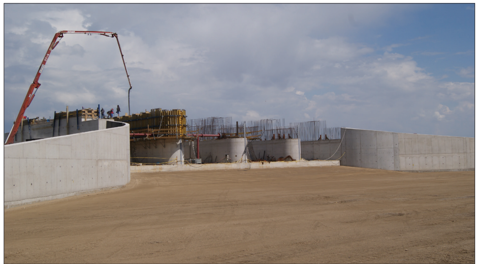
Felső vízbeeresztő műtárgy 4. számú pillérének 3. ütemű betonozása a távtartó segédszerkezetekkel
