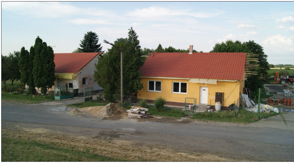
Itceéri gátörtelep rekonstrukciója
