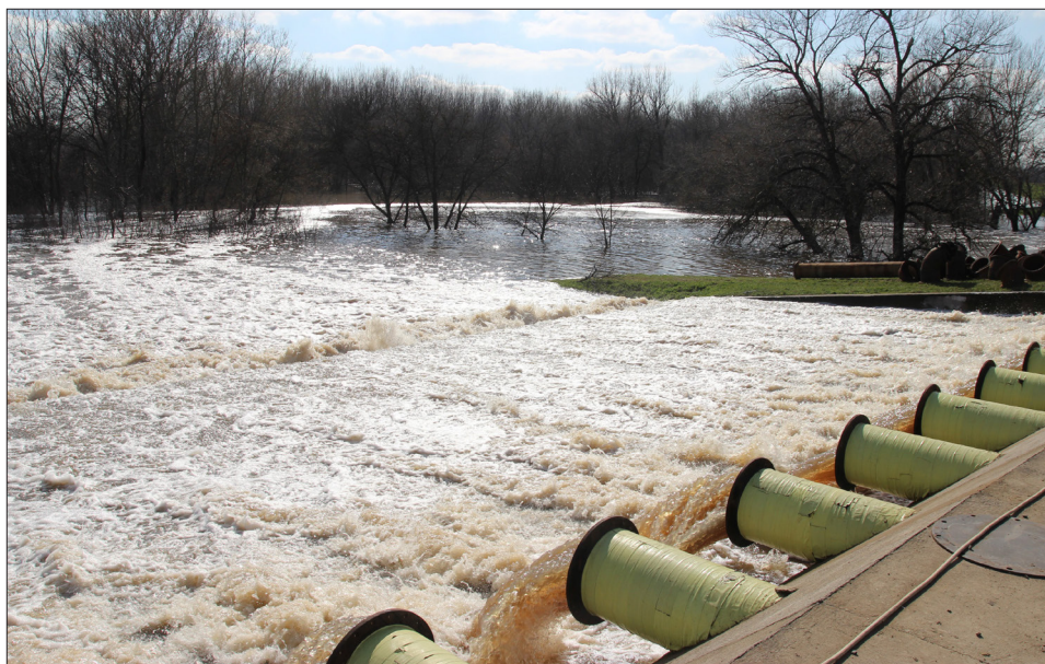
24 egységes provizórium munka közben
