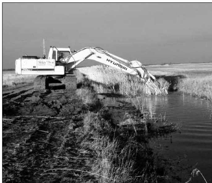
A Kígyósi-főcsatorna kotrása
