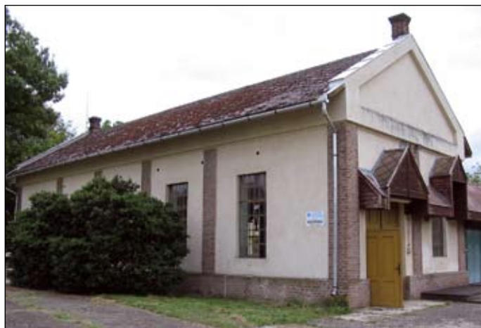
Békésszentandrás II. szivattyútelep
