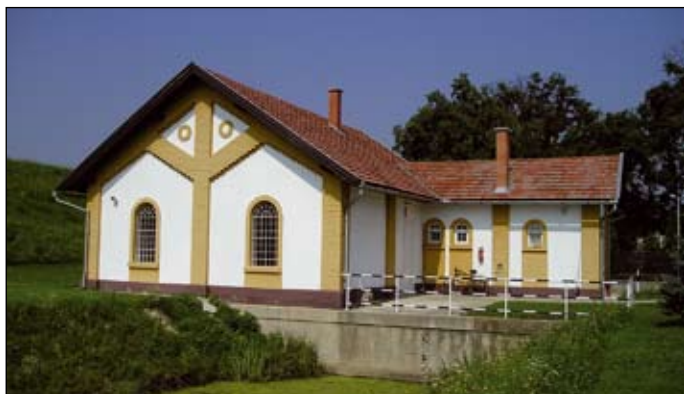
Vargahossza I. szivattyútelep
