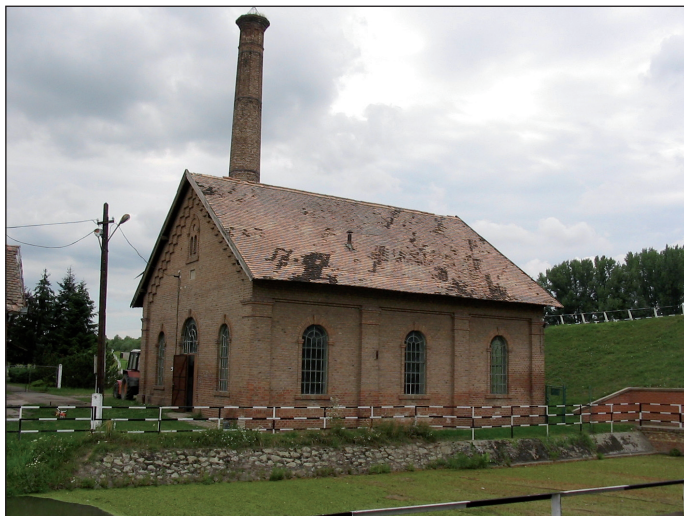
Békés I. szivattyútelep
