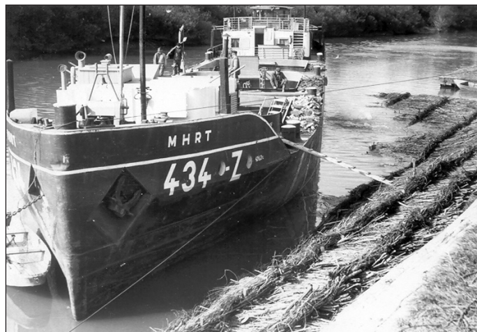
Rőzsepokróc süllyesztés a Kettős-Körösön
