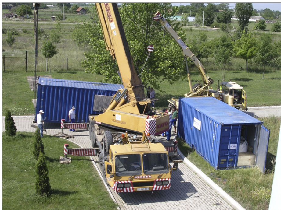
A berendezés beépítése
