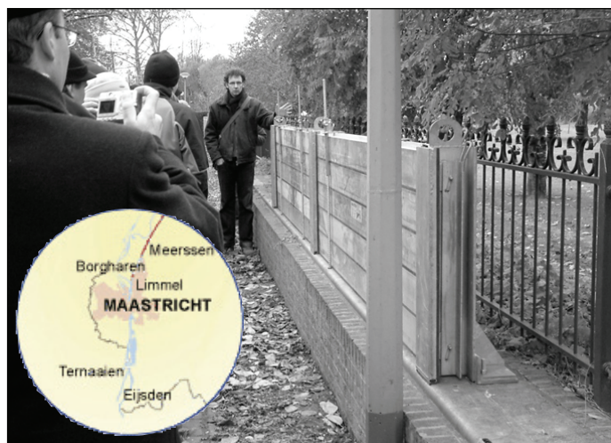
Mobil árvízvédelmi fal a Maas mentén Borgharennél
