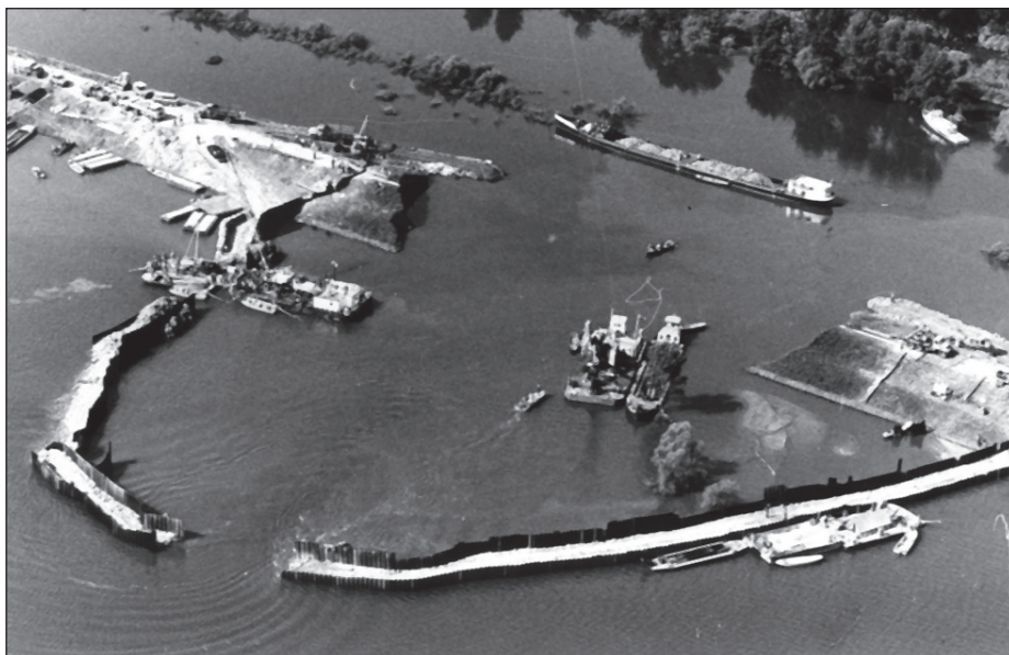
A Kettős-Körös töltés szakadás elzárása
