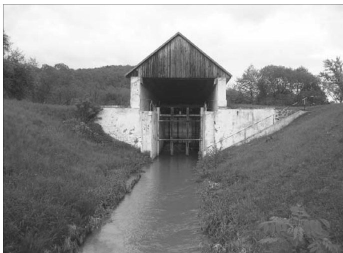
A Malom-csatorna zsilipháza Körösbökénynél
