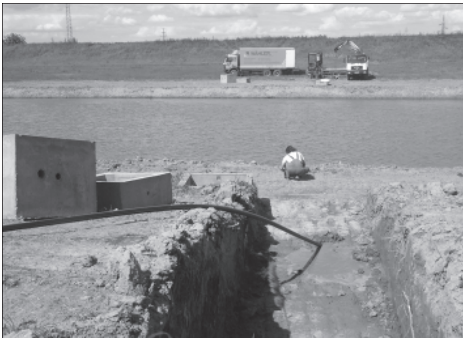
Fehér-Körös csőátvezetés az ultrahangos vízhozammérő hely kialakításához
