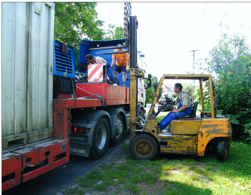
Műhelykonténerek telepítése közben
