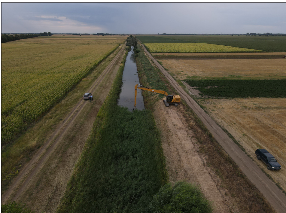
Csatornatisztítás karbantartó géppel a D11-1 csatornán
