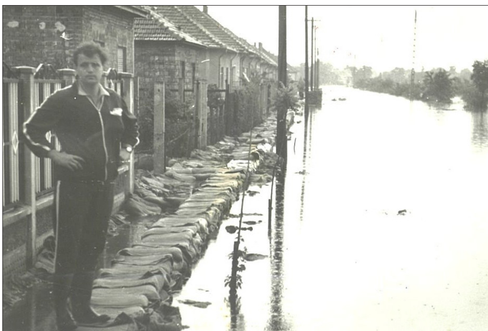
Belvízvédekezés során Békéscsabán
