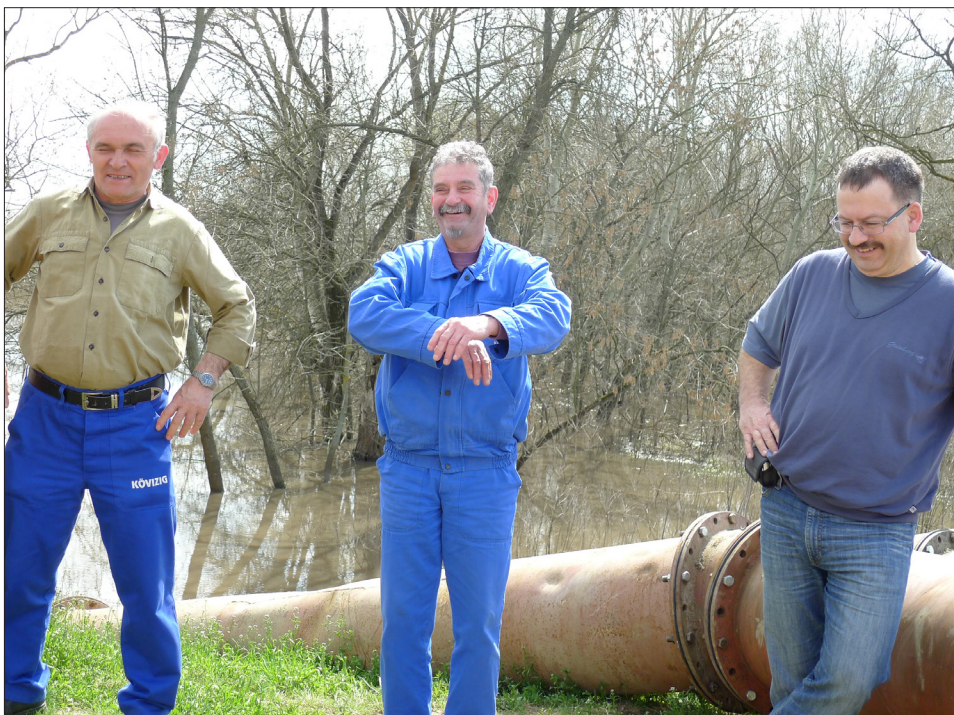
Provizóriumok telepítése közben az Árvízkapunál
