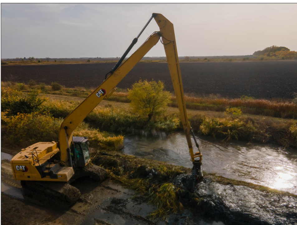
A Taraji-csatorna kotrása
