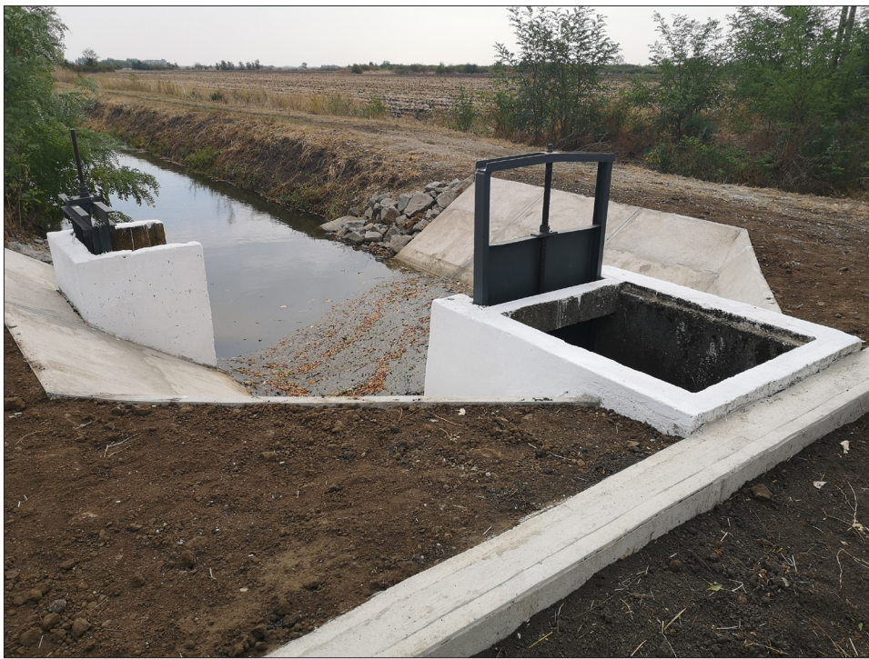
Horgai 102-es csatorna felújított műtárgya
