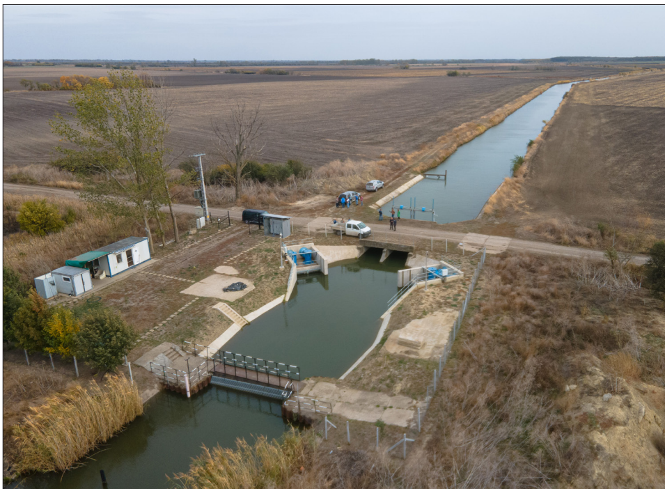
A szemlebizottság a Dögös I. sz. átemelő telepnél
