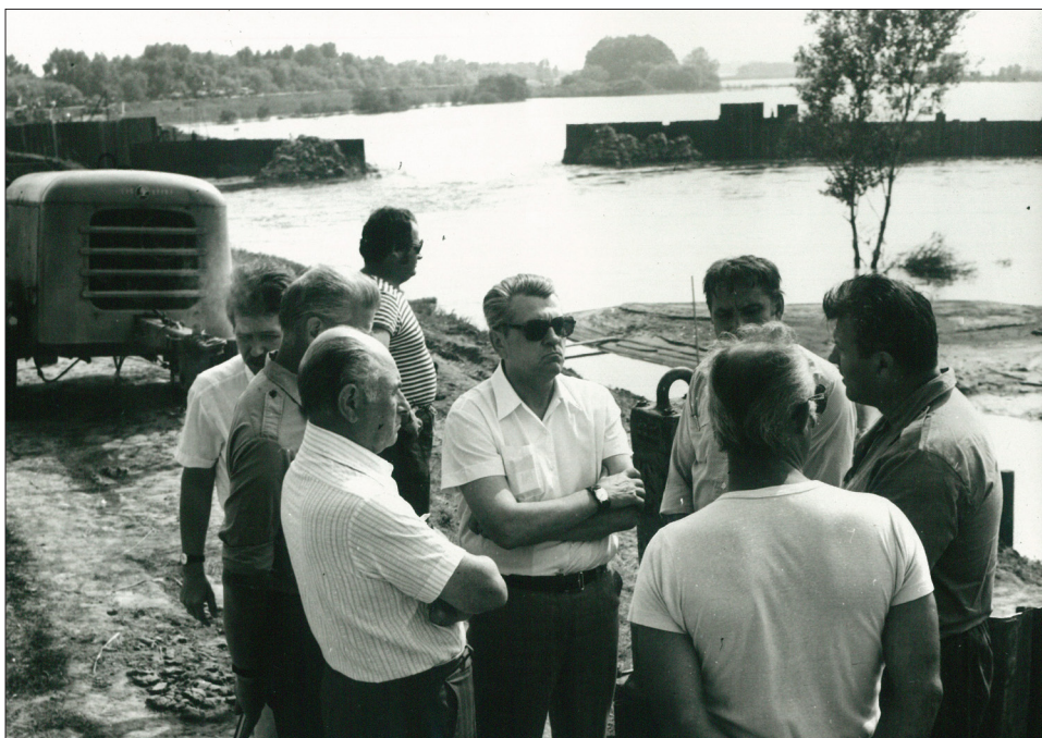
Helyszíni szemle az 1980-as Hosszúfoki töltésszakadásnál
