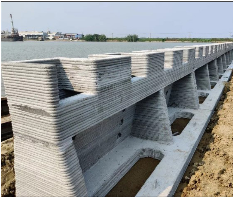
3. ábra: 3D nyomtatással készült árvízvédelmi gát modul WINSUN, Kína [2]
