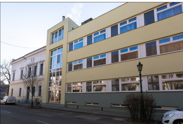
Központi Székház Megyeház utcai homlokzata
