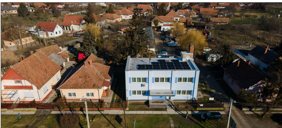
Szeghalmi Szakasz mérnökség irodaépülete
