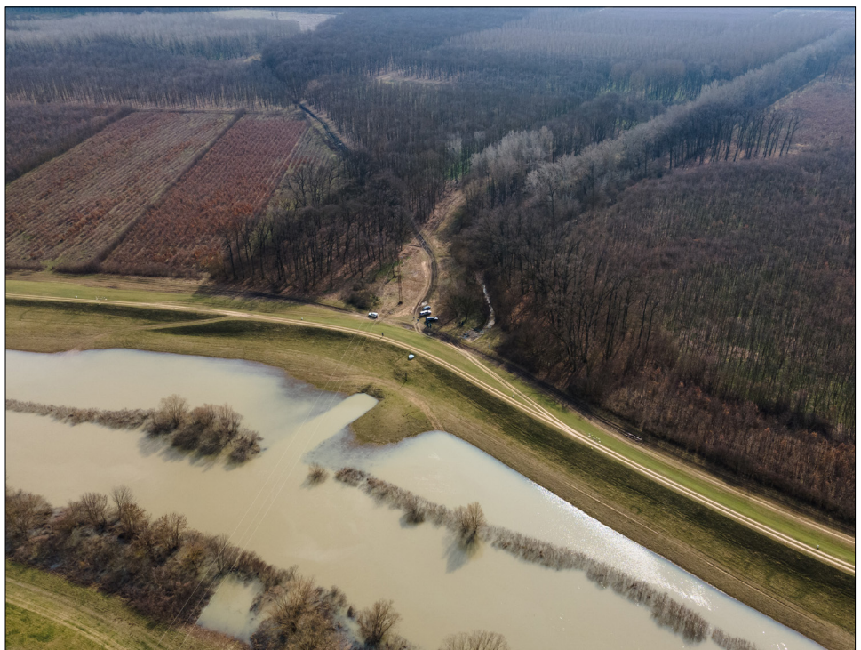
A Mályvádi-erdő vízpótlása a Fekete-Körös árhullámából
