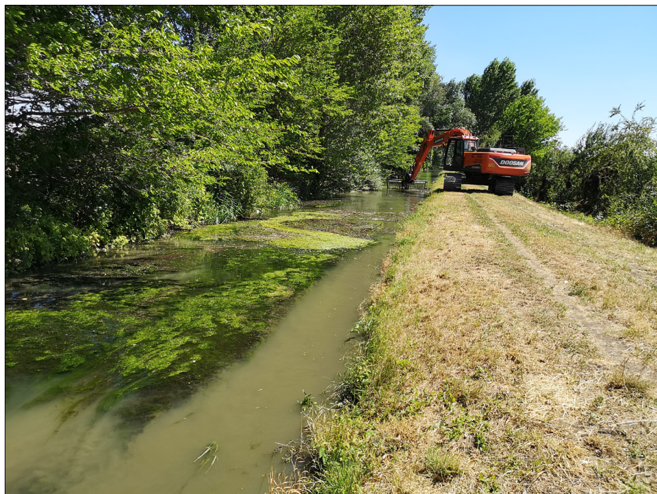
Vízfolyásgátló akadály eltávolítása a Horgai öntözőfőcsatormán
