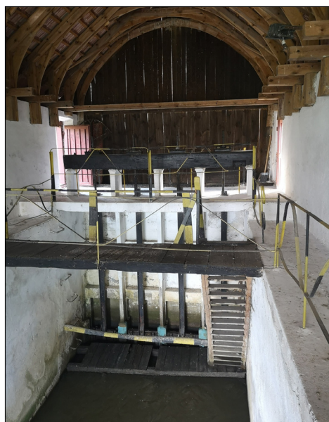
Négynyílású, csavarorsós mozgatású fatáblás zsilip
