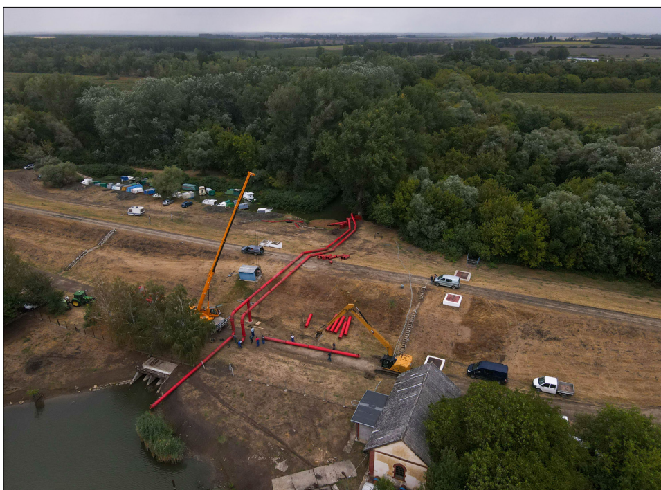
Félhalmi provizorium összeszerelési munkálatai
