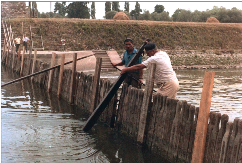
A duzzasztótűk behelyezése
