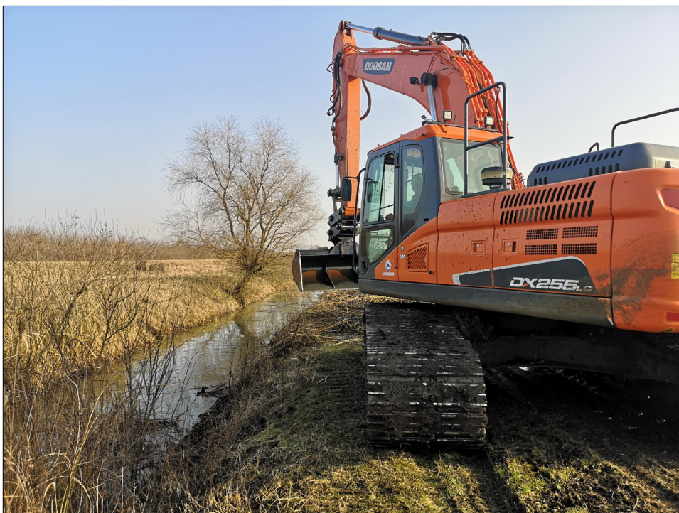
Vízfolyásgátló akadály eltávolítása
