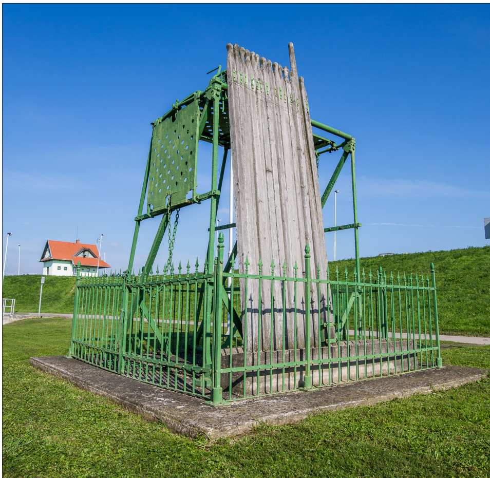
Tűsgát bemutatóhely a Gyulai duzzasztóműnél
