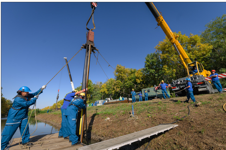
Bemutattuk a szádlemez verés-húzás technikáját a gyakorlaton
