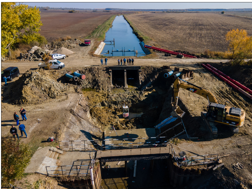
A Dögös-Kákafoki I. átemelő szivattyútelep elektrifikálásának II. üteme
