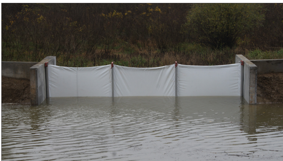
Két lezárófal közé épített mobilfal mezőnként külön ponyvából kialakítva
