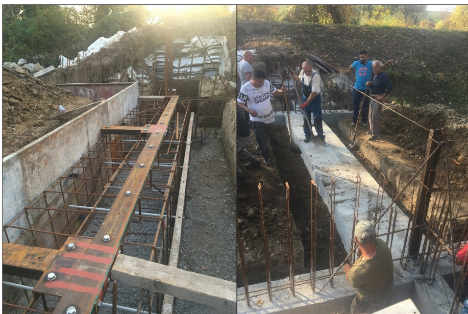
Támfal és tartóoszlop alapok készítése 2019. októberében
