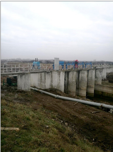
Tulcai zsilip felújítás előtt
