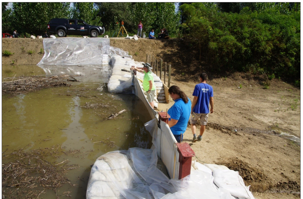
2018. szeptember 11-én végzett próba példa a homokzsák-mobilfal kapcsolat kialakítására
