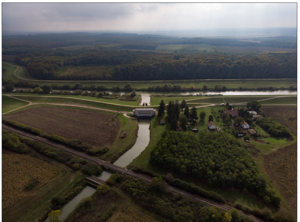
A Sarkad-Sitkai szivattyútelep
