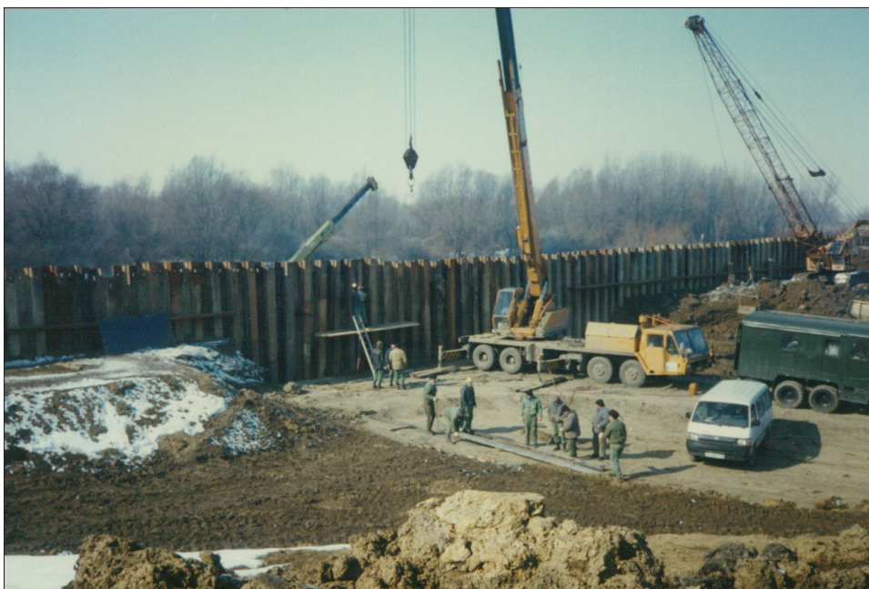
Az ideiglenes elzárás helyreállítása és megerősítése a Mergesi árvízi szükségtározónál a víz visszavonulása után
