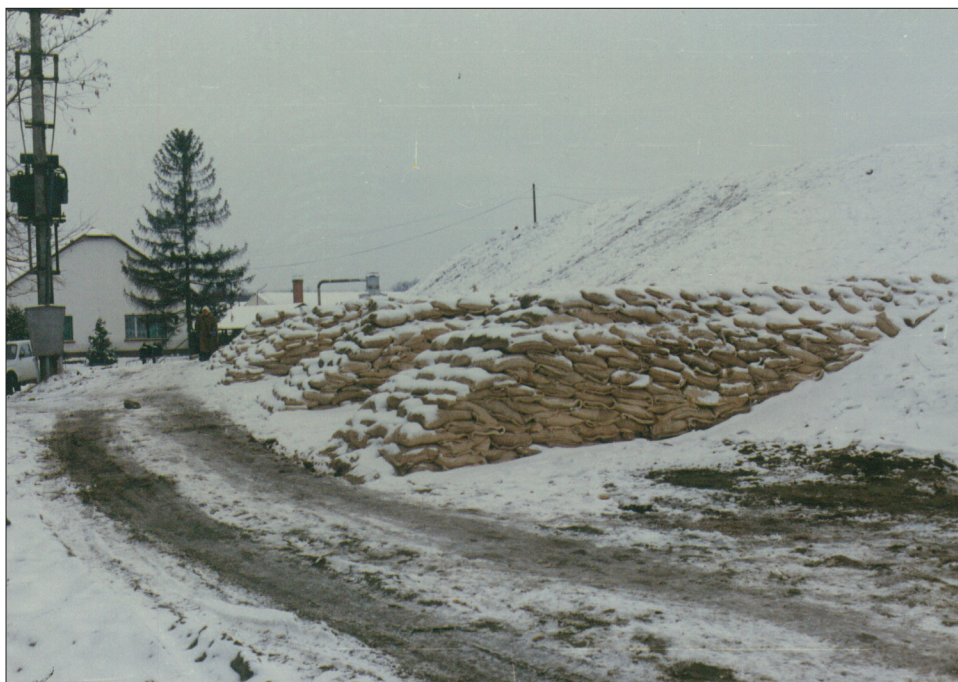
Bordás megtámasztás az I. sz. szivattyútelep mellett
