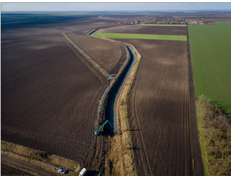
A Dögösi-főcsatorna iszapkotrása
