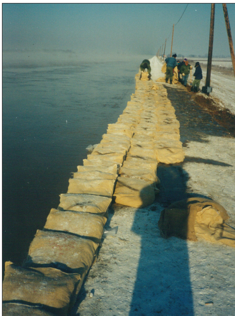
A Fehér-Körös jobb partján nyúlgát építés
