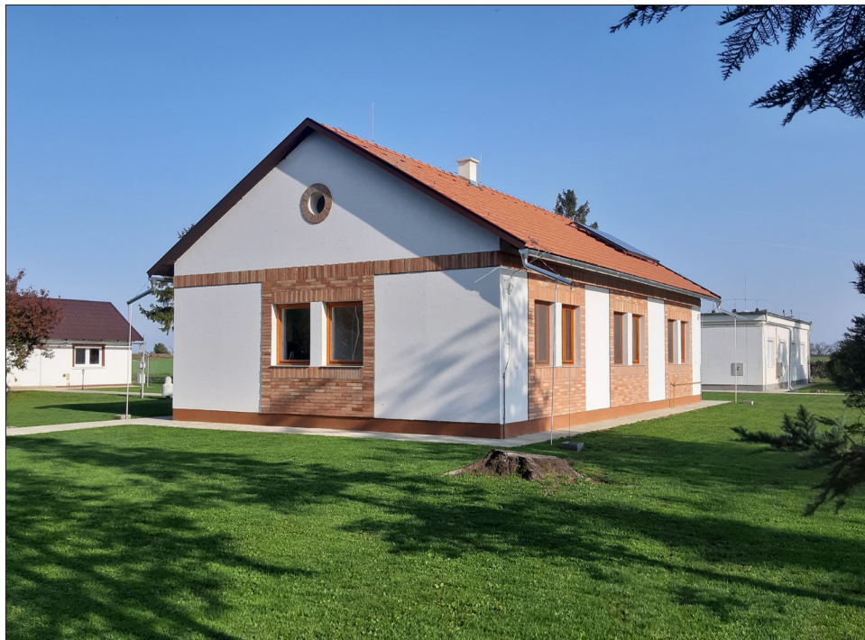
A Peresi gátörtelep új épülete
