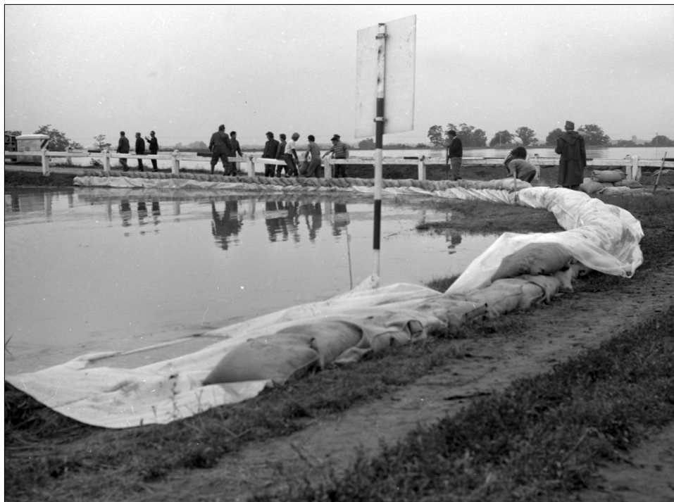
Nyúlgát építés a Fekete-Körös töltésén
