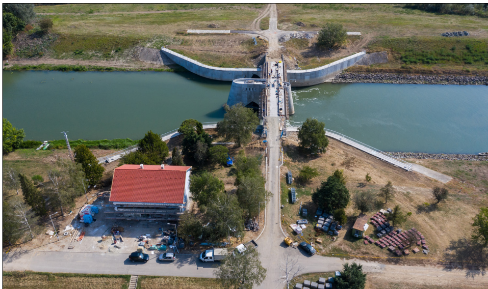
Jó ütemben halad a duzzasztómű és a kezelőépület rekonstrukciója
