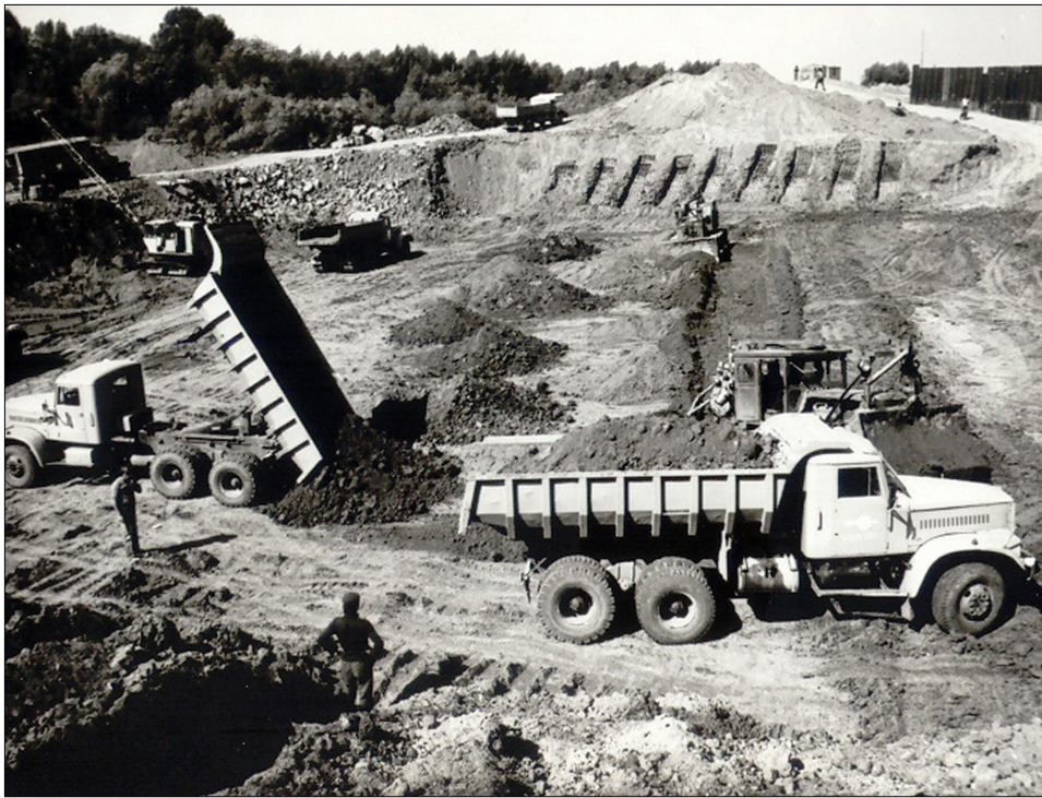
A Kettős-Körös átszakadt védtöltésének helyreállítása
