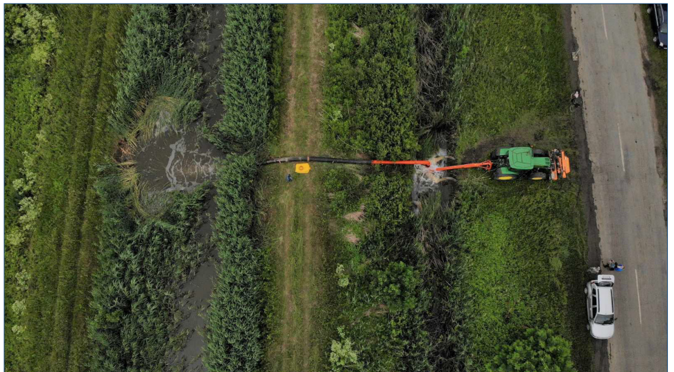
Kamut közelében mobilszivattyúzás a belterületről érkező belvizek áttemelésére
