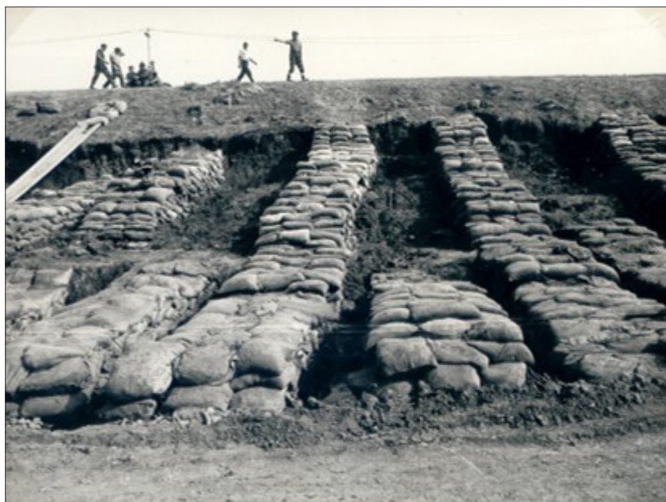
Bordás megtámasztás építés közben a Sebes-Körös jobb part 10,700 fm-ben
