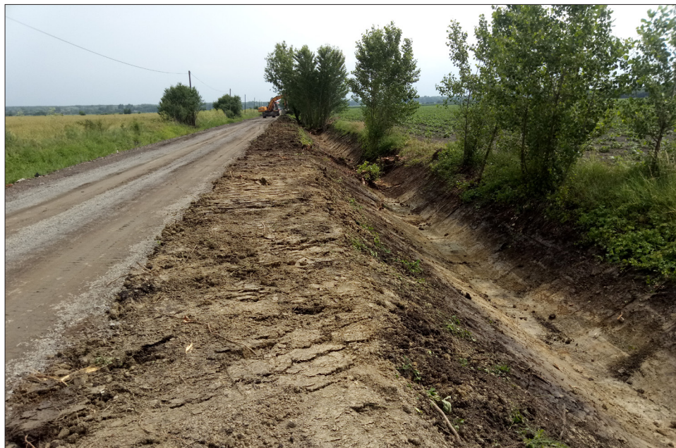
A Zsófiamajori bekötőút felújítása
