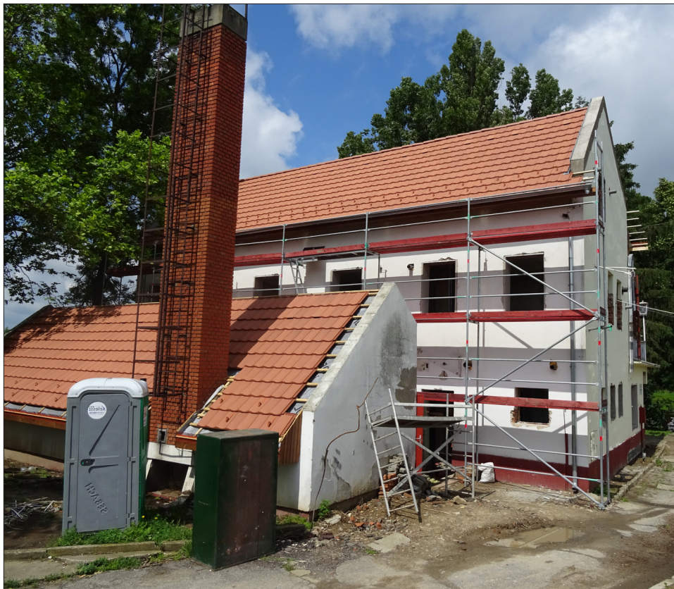
Szanazugi Árvízvédelmi Központ felújított tetővel
