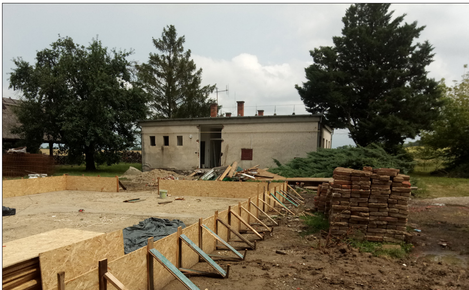
Peresi gátórház alapozási munkái
