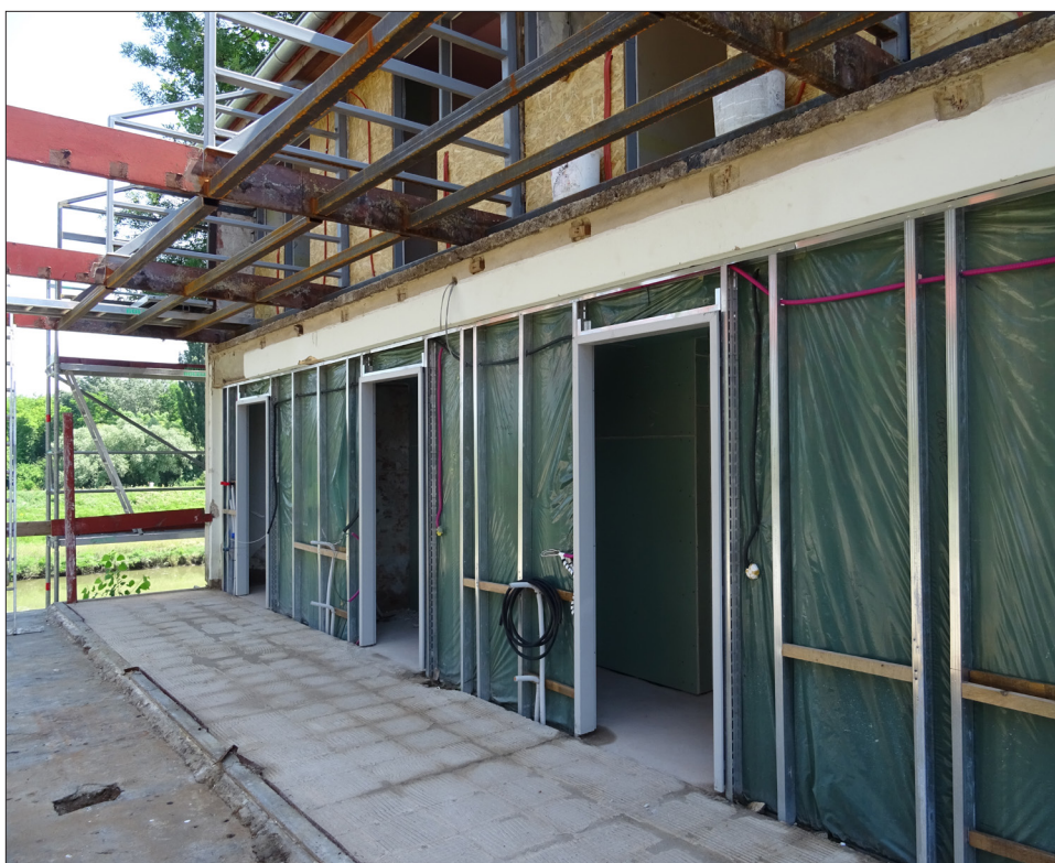
Tetőszerkezetet erősítő és kitámasztó acélszerkezet a második emeleti szobáknál
