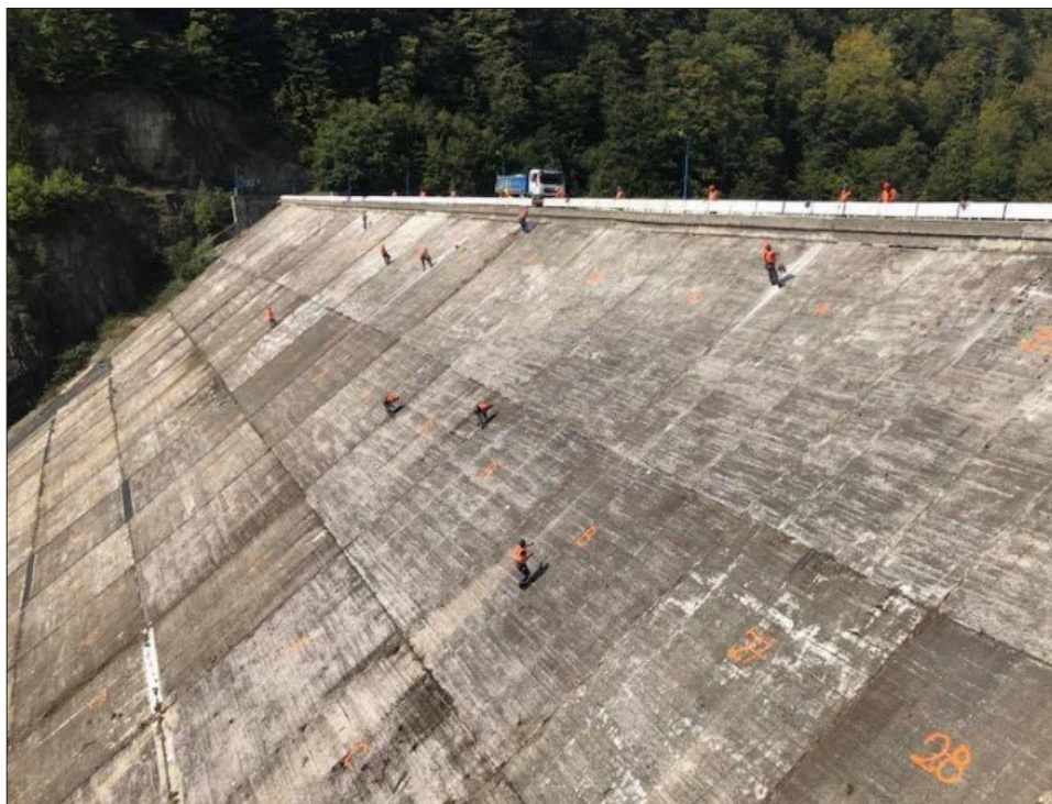
Alpin technikás munkavégzés a víz oldali rézsűn
