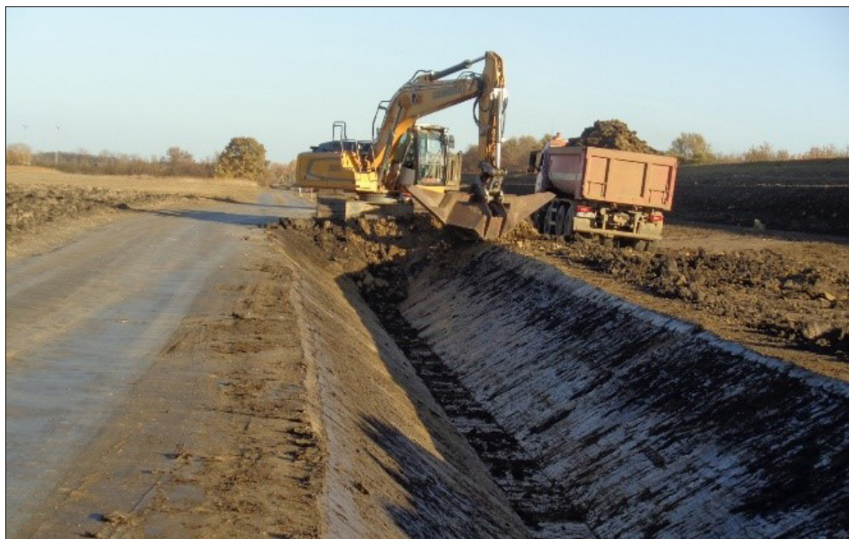
Nyílt szivárgó csatorna építése
