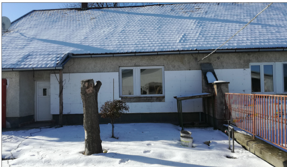
Szolgalati lakások külső hőszigetelése
