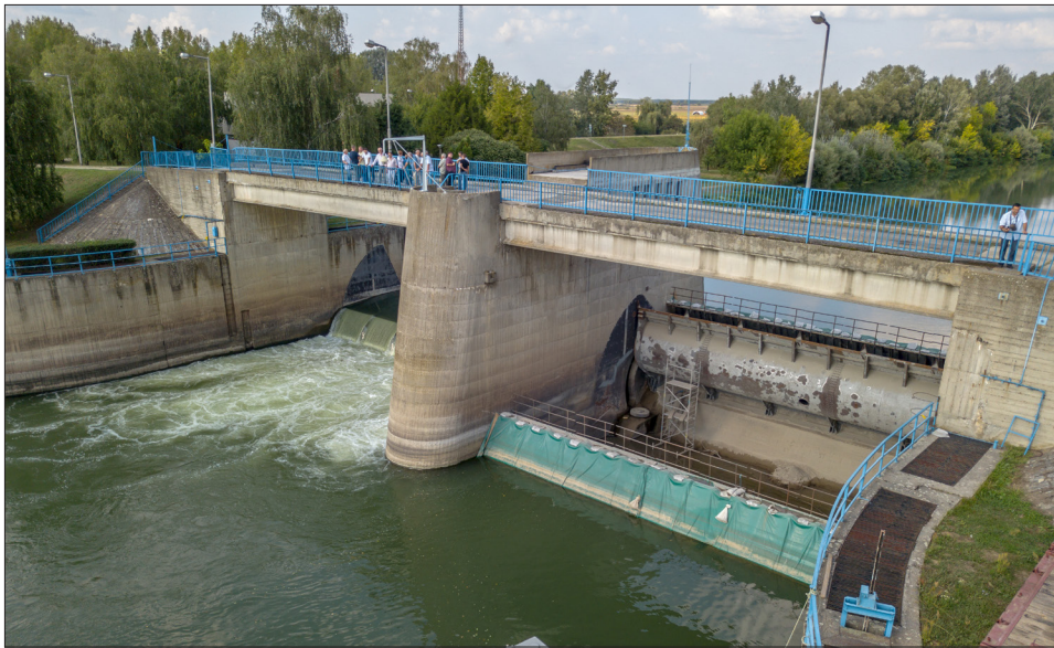
Főelzáró tábla rekonstrukció a víztelenített munkatérben
