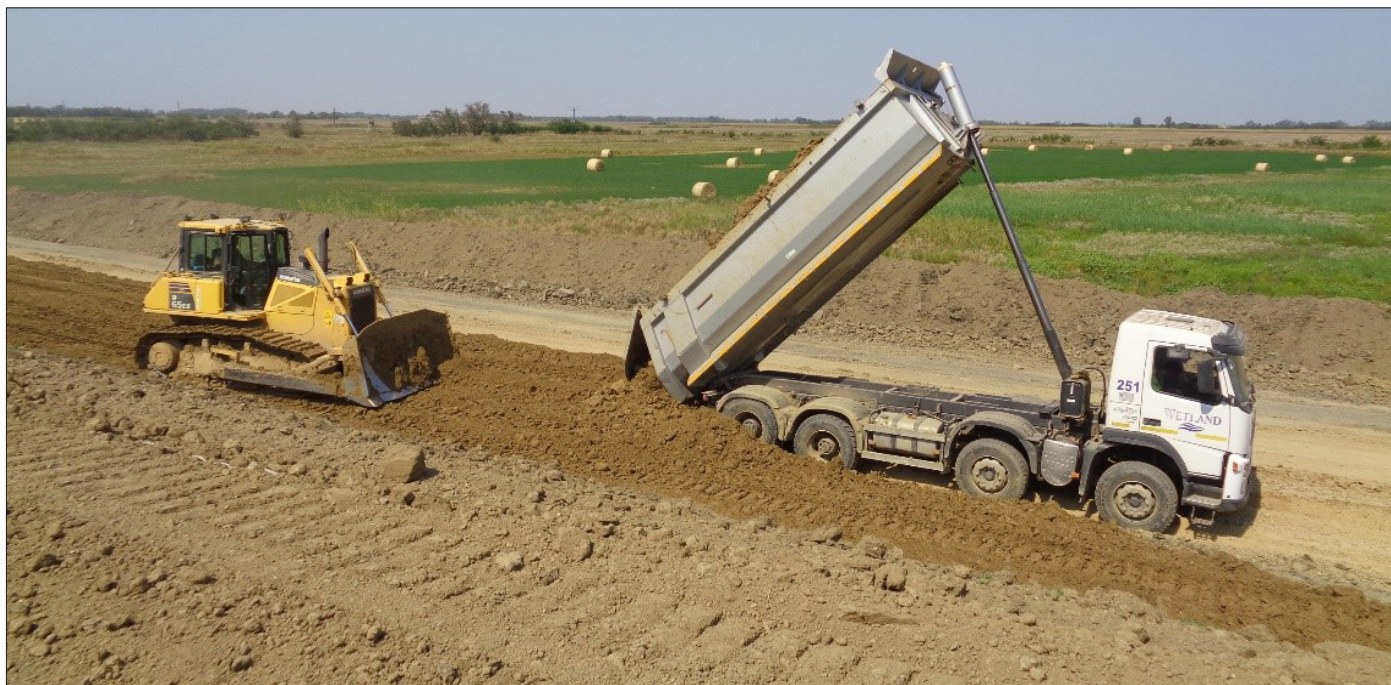
A háttöltés építés ürítés és terítés munkafázisa a munkaterületen
