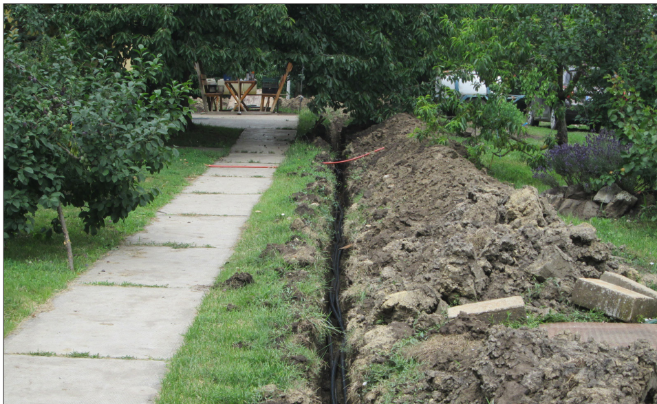
A bekötő vízvezeték fektetése
