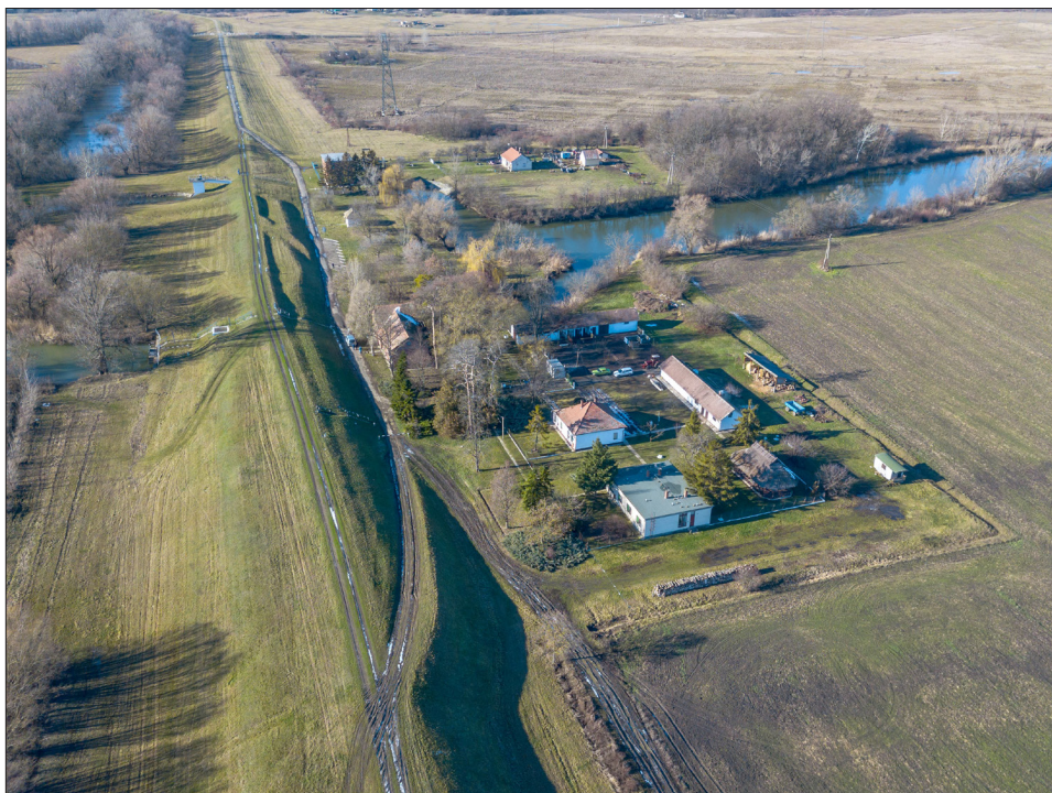
A fejlesztéssel érintett töltésszakasz és gátörtelep
