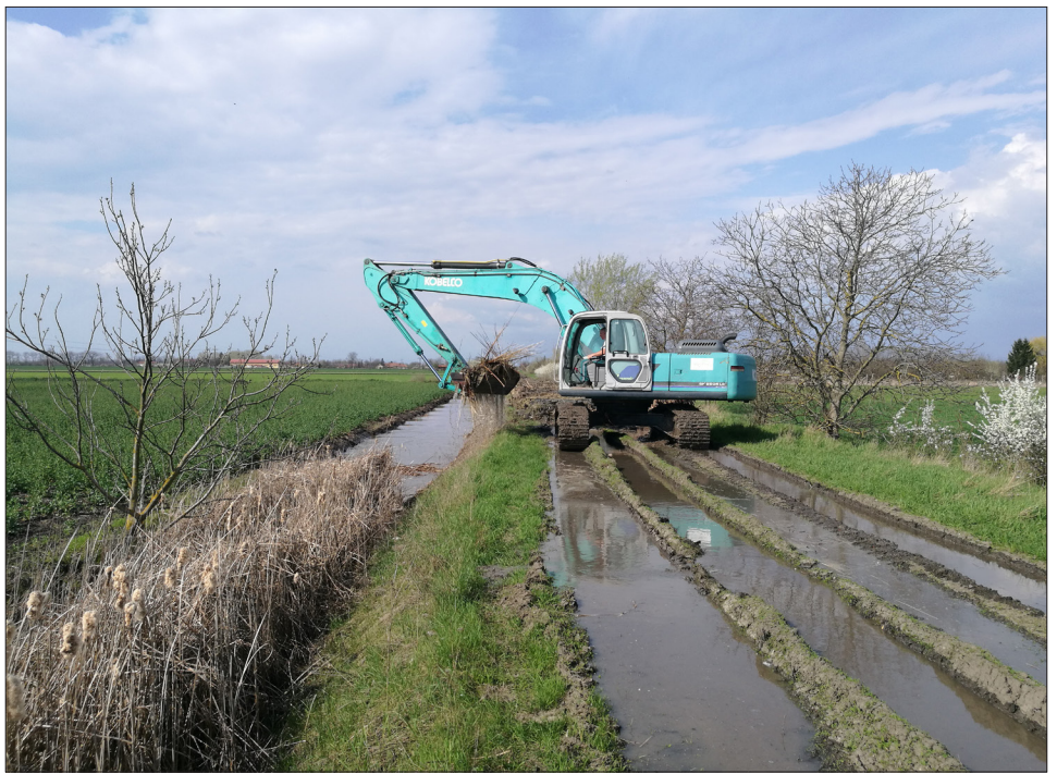
Izapeltávolítás a Borosgyáni IV-es csatornán
