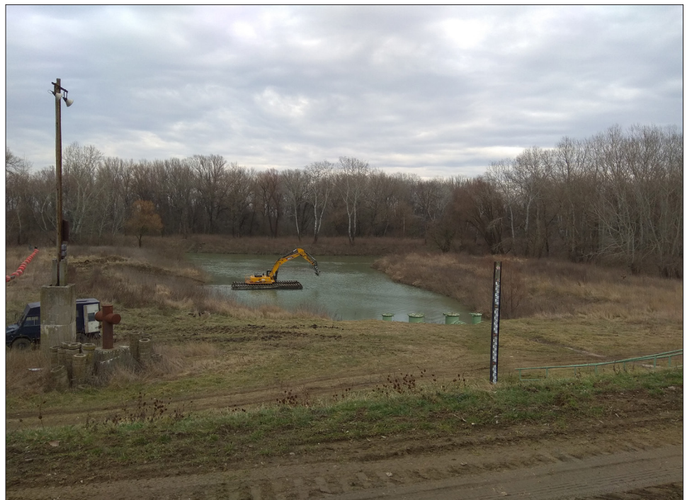
NK-XIV. öntözőrendszer tápcsatornájának hidromechanizációs kotrása
