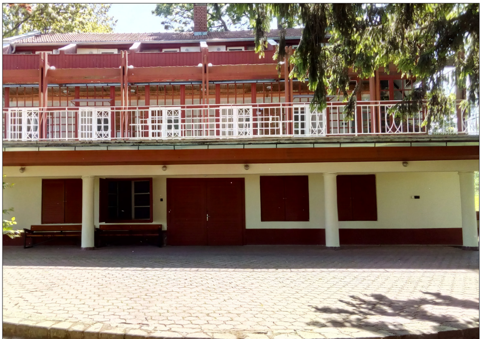
A felújítás előtt álló védelmi központ épülete
