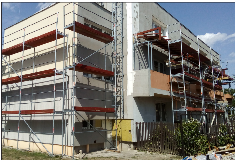
Gyula, Nürnbergi u. 18. számú épület hőszigetelése
