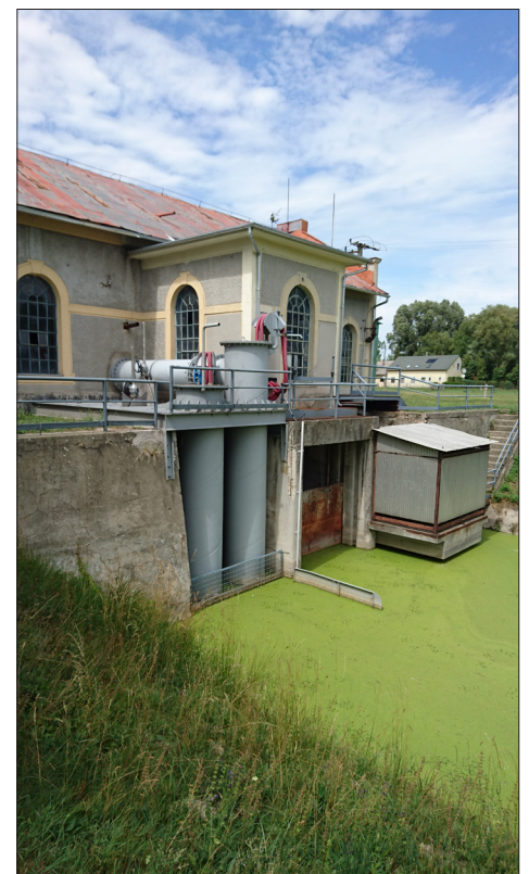
Az épület az új gépek beépítése után
