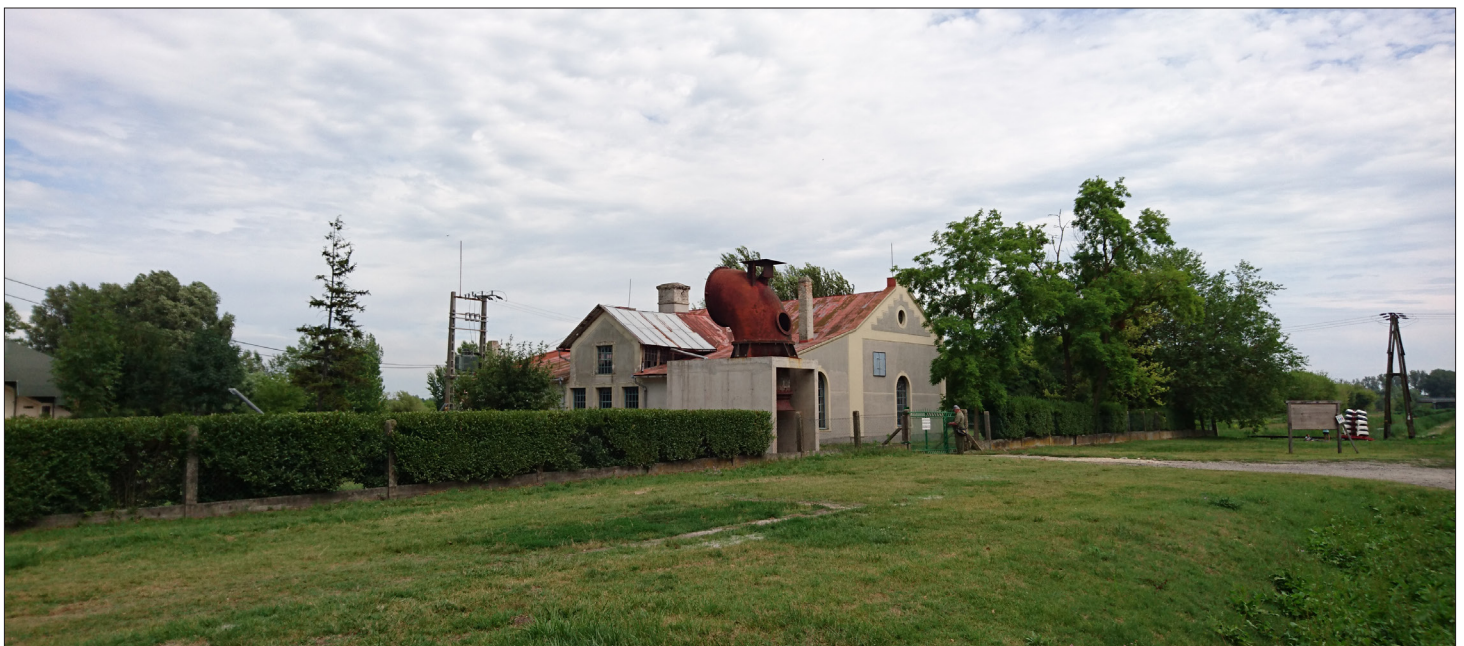
A fenyvesi szivattyútelep
