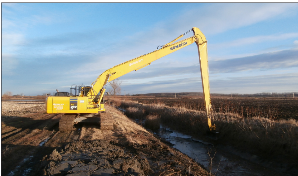
A Telki-Peresi főcsatorna kotrása - 2016. november
