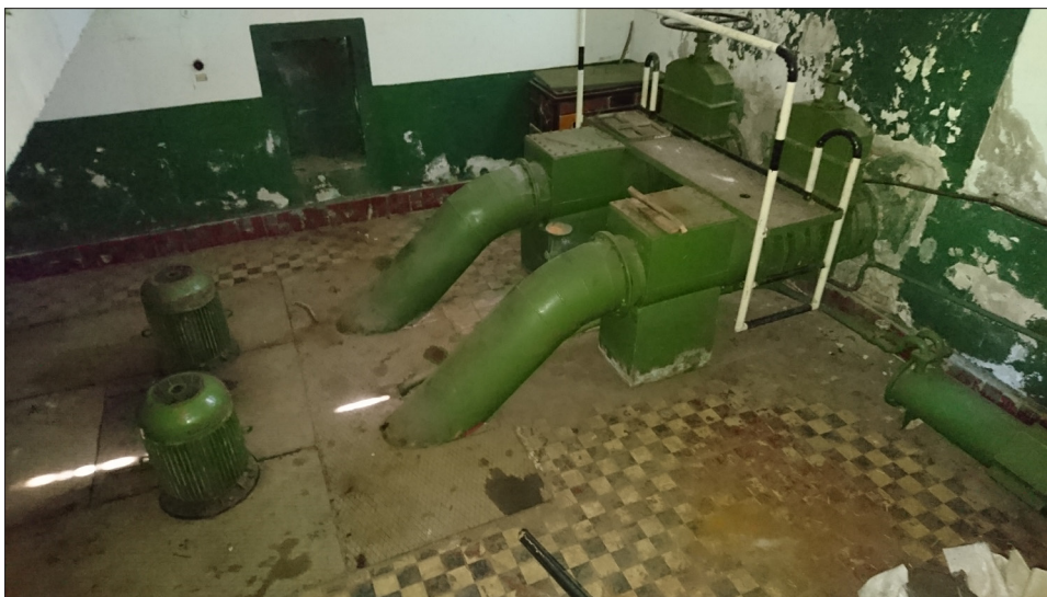
A Németzugi szivattyútelep jelenlegi állapotában
