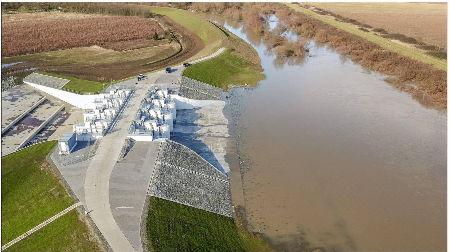
A román határ mellett található Mályvádi árvízi szükségtározó felső beeresztő műtárgya
