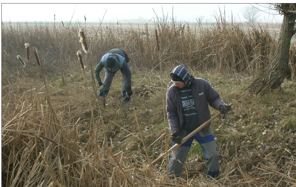
Fazekaszug, szivárgó csatorna takarítása
