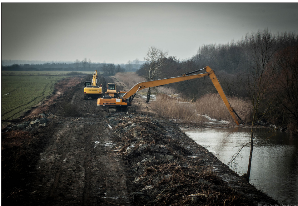
Csatorna kotrás fenntartó géppel
