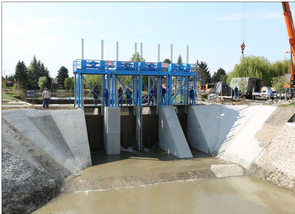
A torkolati zsilipnél elkészült a műtárgy beton szerkezete
