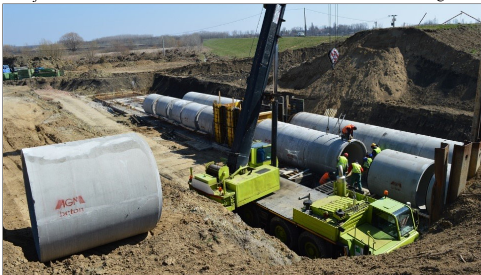
Vízvisszavezető műtárgy betoncsövek beemelése
