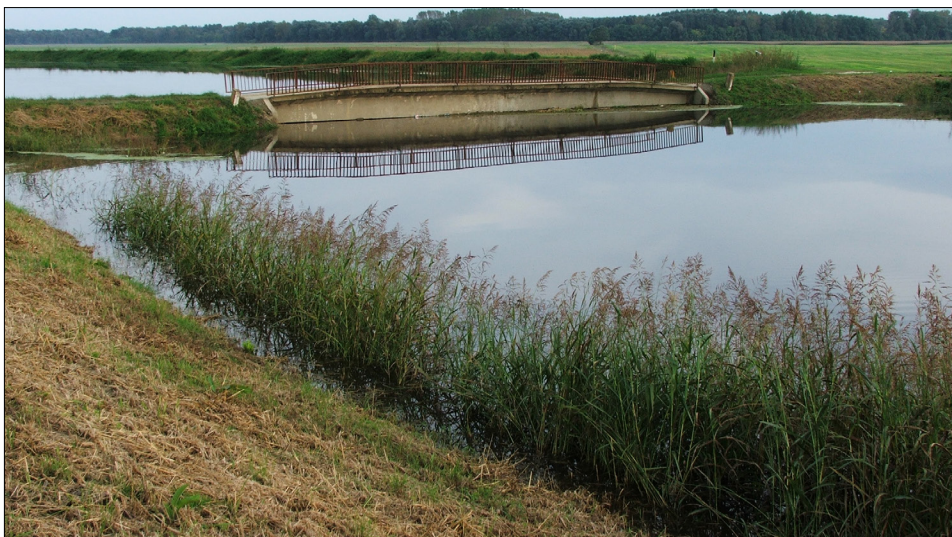
A Fekete-víz hídja tetőzéskor
