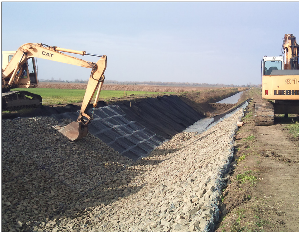
Réno matrac építése a K-1 öntözőcsatornán
