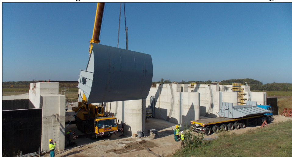
Szegmenstábla beemelés a mályvádi felső vízbeeresztő műtárgynál
