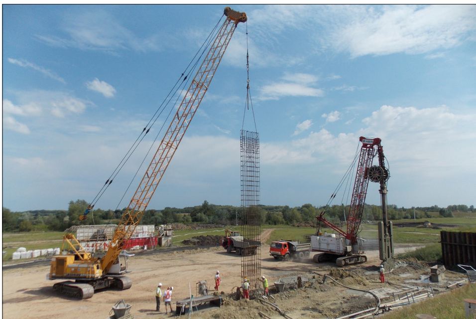
Kisdelta vízbeeresztő műtárgy résalapozása
