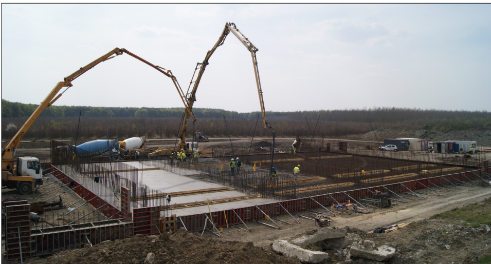
Az alsó vízbeeresztő műtárgy alaplemezeinek betonozása Mályvádön
