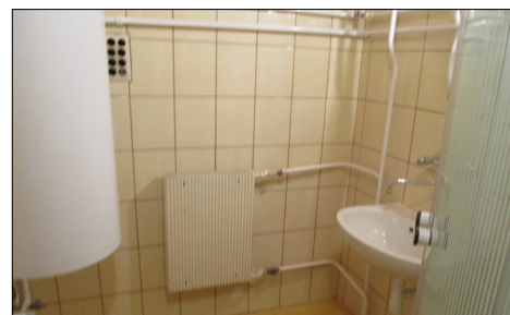
Felújított vizesblokk a Szanazugi védelmi központban
