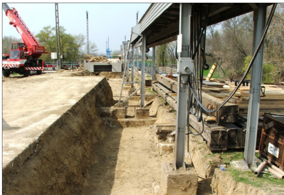
Vasbeton lemez bebetonozása
