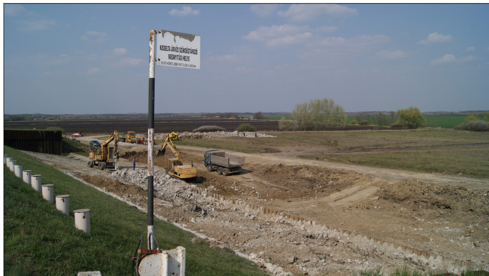
A Kisdelta szükségtározó robbantásos megnyitási helyének részleges elbontása
