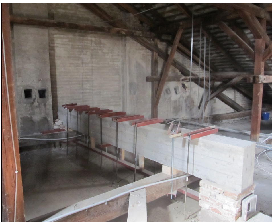
Kiváltó gerendához felhúzott padlásfödém
