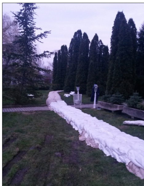
Az Ady Endre utcában a Mária Hotel előtt kiépített 2 zsák széles és 3 zsák magas, 70 fm hosszú fóliázott nyúlgát (részlete)
