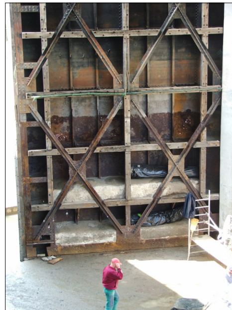
Víz alatti acélszerkezetek felmérése
