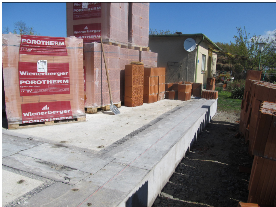
Falazási munkák előkészületei a csíkéri gátórtelepen
