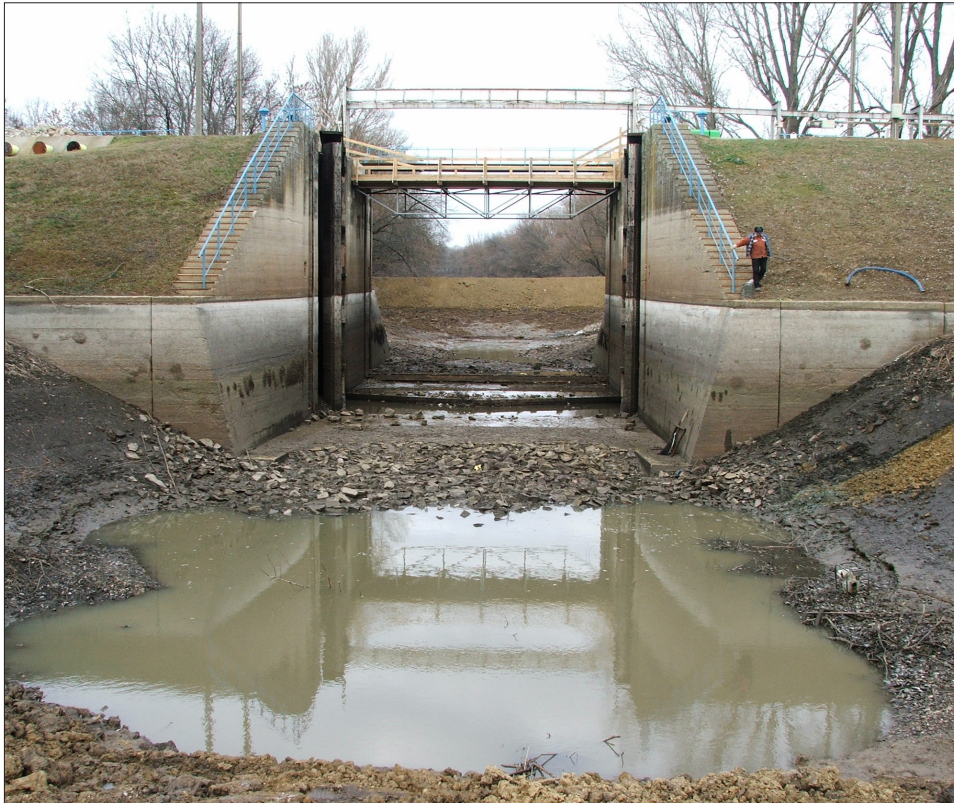
Az árvízkapu víztelenített munkafelülete
