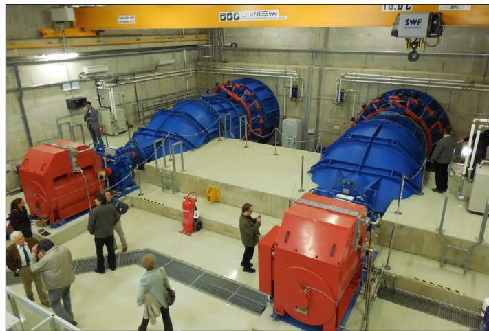
A békésszentandrási vízierőmű gépháza
