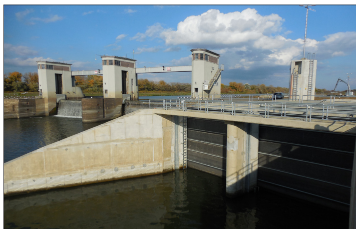
A vízierőmű alvízi oldala
