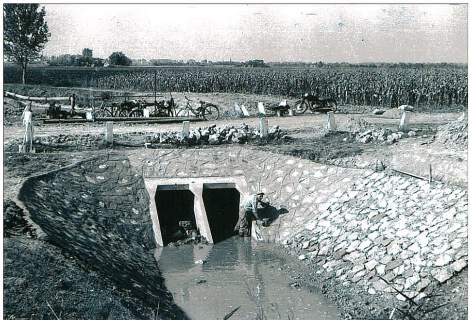
Gyula-Kispél-Eleki csatorna mőtárgy építés és kőburkolat készítés (1961.)
