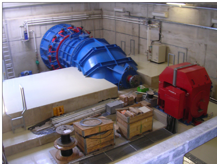
Baloldali csőturbina és generátor
