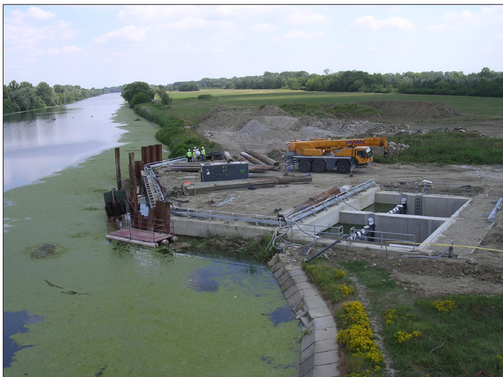
Megkerülő beömlő csatorna kiágazása
