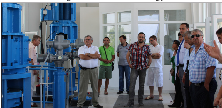
A Malomfoki szivattyútelep
