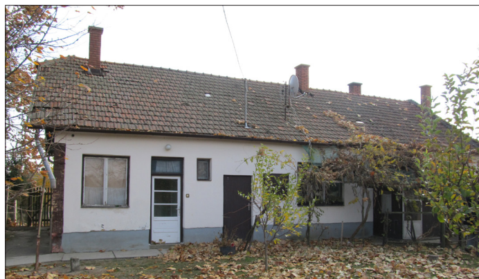
A Remetei gátörtelep a rekonstrukció előtt
