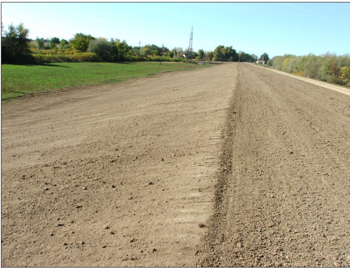
Októberben befejeződött a töltésépítésre és a feltöltésre alkalmas - az építés kapcsán feleslegessé vált 12 979 m 3 - föld deponálása a Hármas-Körös bp.i töltés mentett oldalán a 41+600-42+250 tkm szelvények között.
