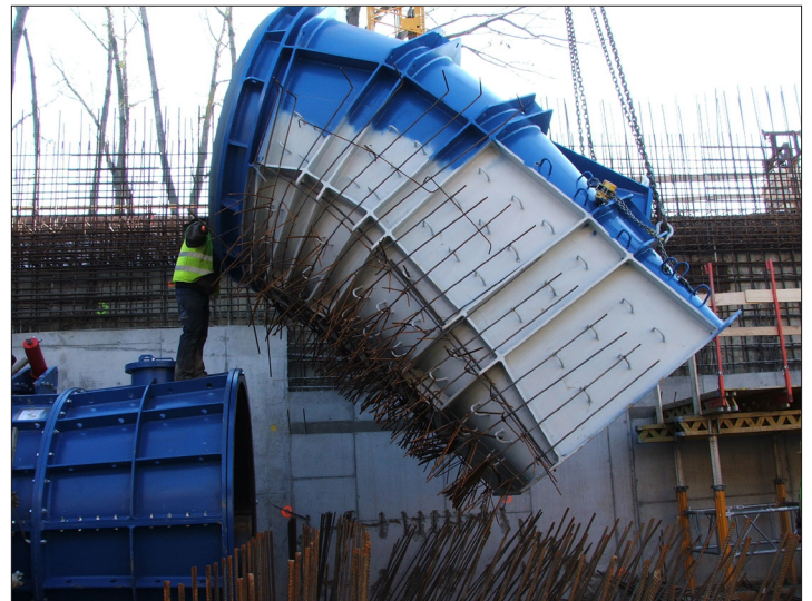
szerkezeteknek a vasszerelése és betonozása történik. Az építési munkák várható befejezési időpontja 2013. 03. 30.
