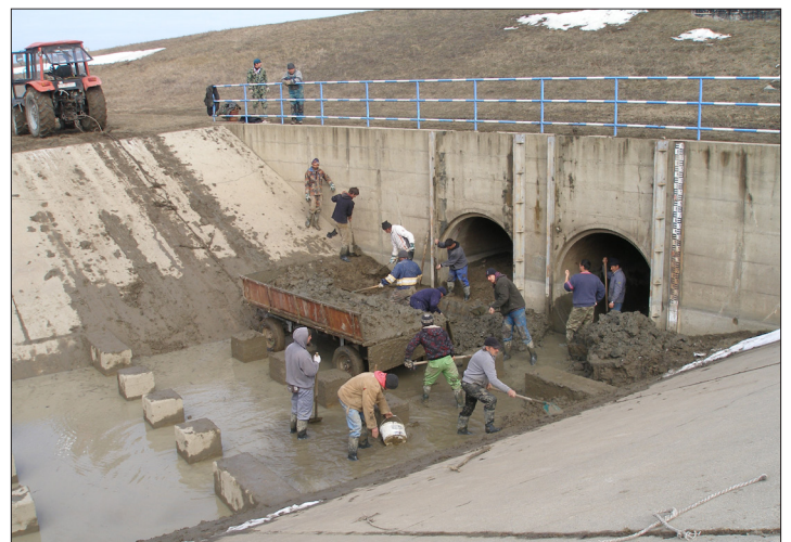
Mérgesi vízviszsaeresztő műtárgy, Köröstarcsa iszaptalanítás
