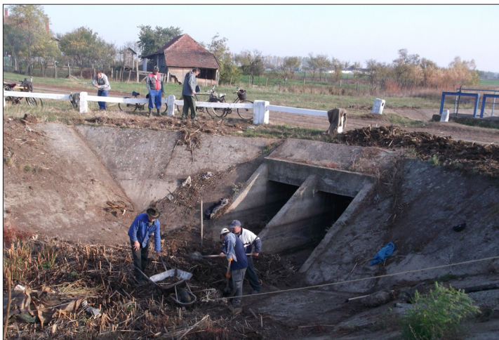
Dióvári főcsatorna - Áteresz iszaptalanítás
