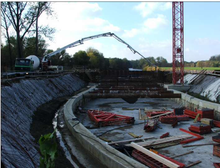
December elején a turbinák acélszerkezeteit beépítették, azóta az erőművi blokk felmenő falainak és a belső másodlagos
