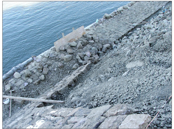
Október végén megkezdtek és decemberben a téliesre fordult időjárás miatt felfüggesztették az alvízi részü rakott kőburkolatának és a fenék szórt kőburkolatának építését.
