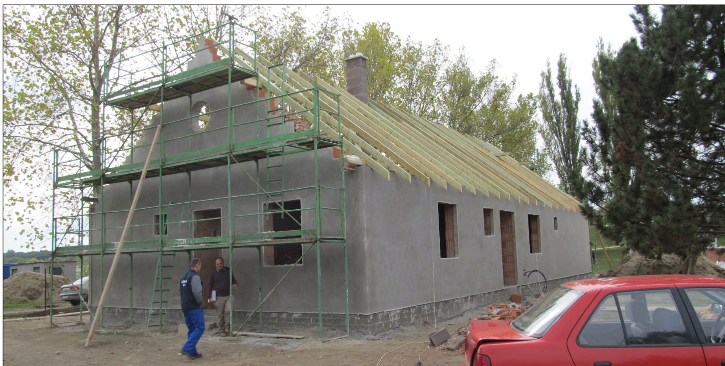
Vakolás, tetőszerkezet ácsolása
