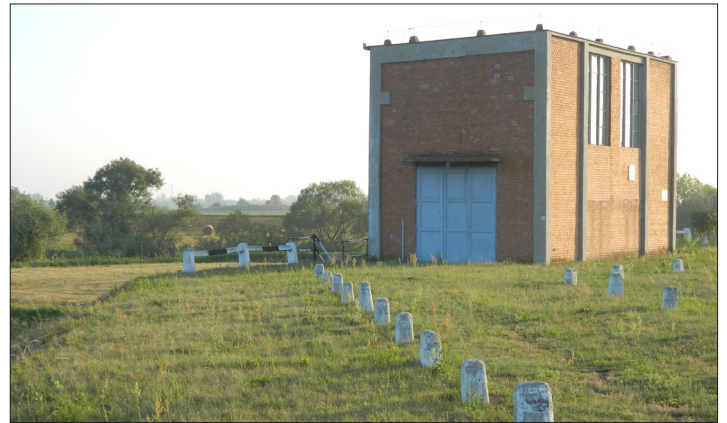
A vízkivételi műtárgy épülete
