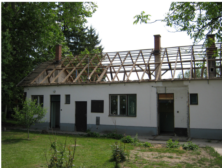
Tetőszerkezet bontása
