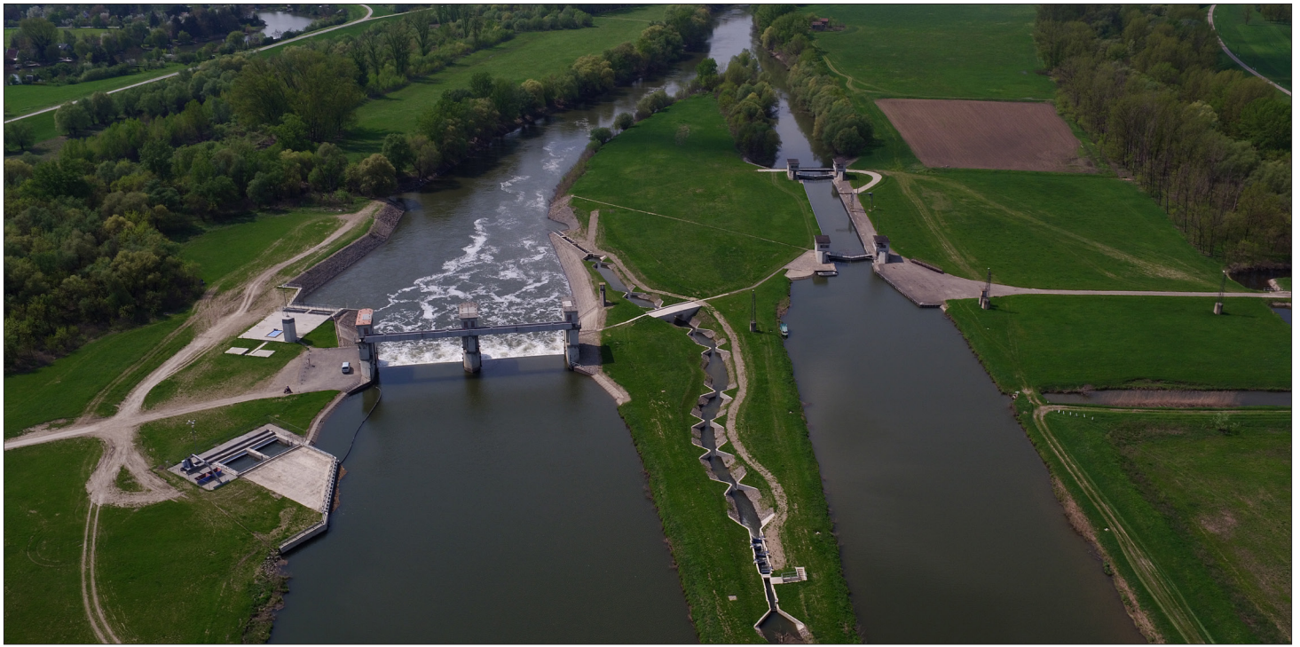
Balról a vízerőmű, középen a duzzasztómű, mellette a hallépcső, jobbról a hajószilip látható
