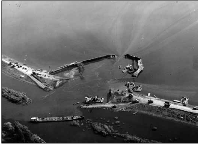
2. kép. Folyik a vízviszavezetés az elöntött területről, az ideiglenes elzárási munkák megnyitott kapukon keresztül
