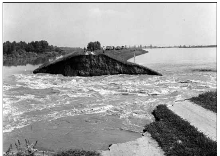
1. kép. A Kettős-Körös jobb parti töltése Hosszúfoknál, néhány órával a töltésszakadás után
