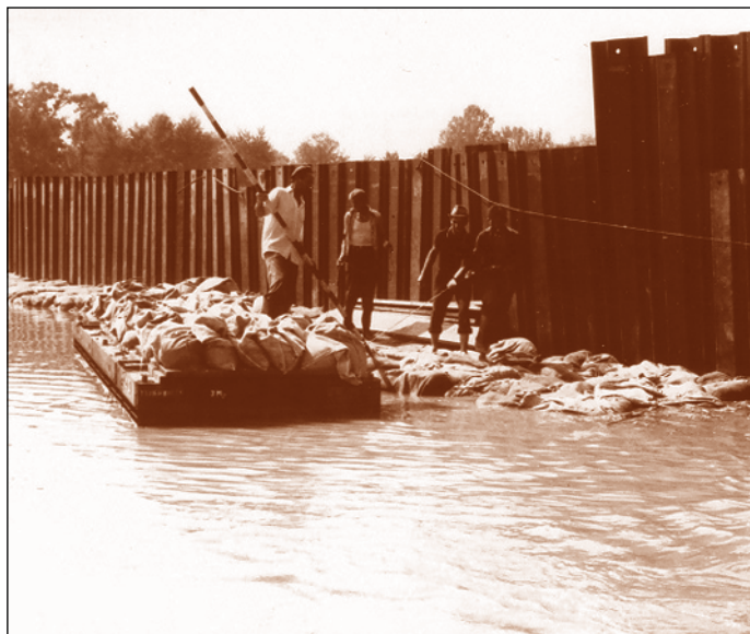
Kettős-Körös jobb parti töltésszakadás ideiglenes elzárása, CS-2 lemezekből, homokzsákos megtámasztással
