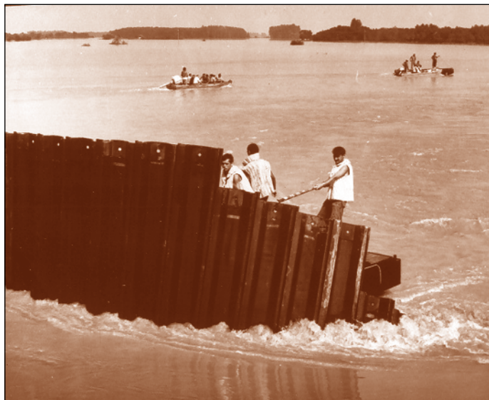
Kettős-Körös jobb parti töltésszakadás első lemezsorának építése
