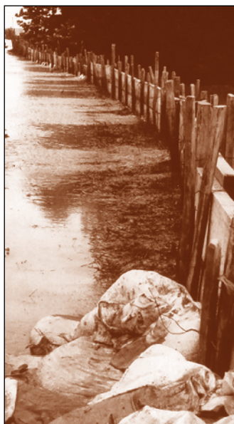
Hosszúfoki-főcsatorna, homokzsákkal megtámasztott pallósor
