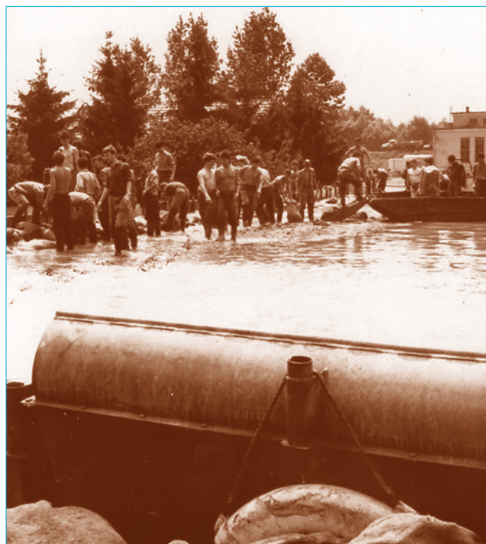
Hosszúfoki-főcsatornánál nyúlgátépítés a honvédséggel
