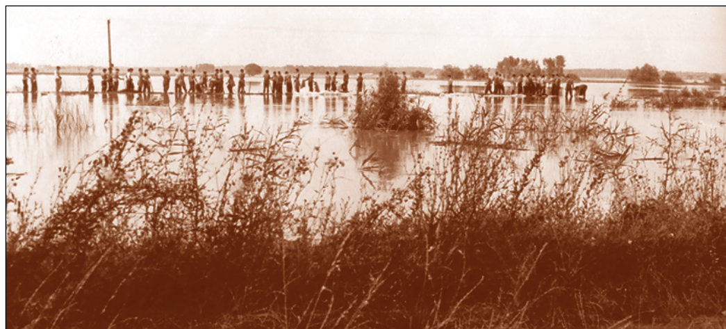
Hosszúfoki főcsatorna, jobb parti nyúlgátépítés
