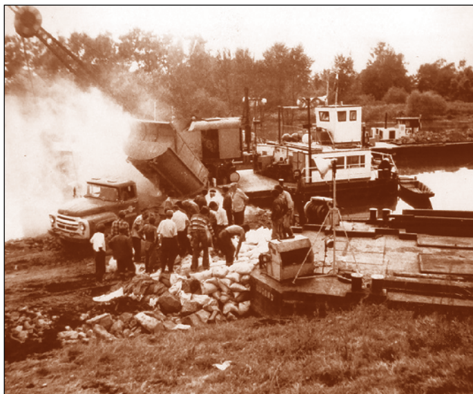
A Kettős-Körös jobb parti töltésszakadásnál hullámtéri kógáté építése
