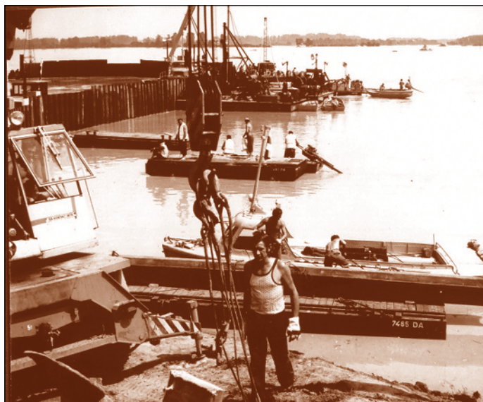
Kettős-Körös jobb parti töltésszakadás ideiglenes elzárása, CS-2 lemezek rakodása
