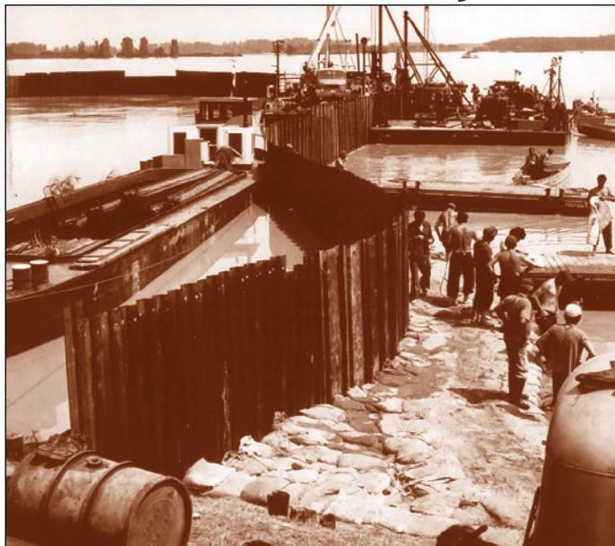
Kettős-Körös jobb parti töltésszakadás ideiglenes elzárása
