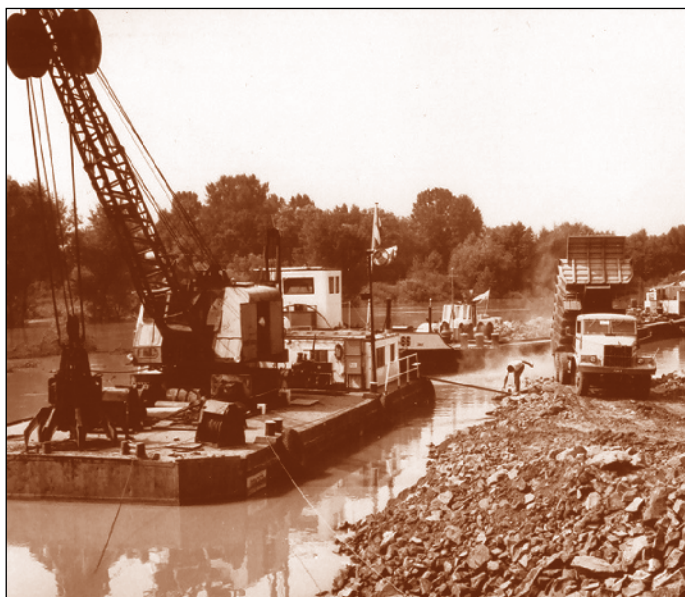
A Kettős-Körös jobb parti töltésszakadásnál hullámtéri kógáté építése
